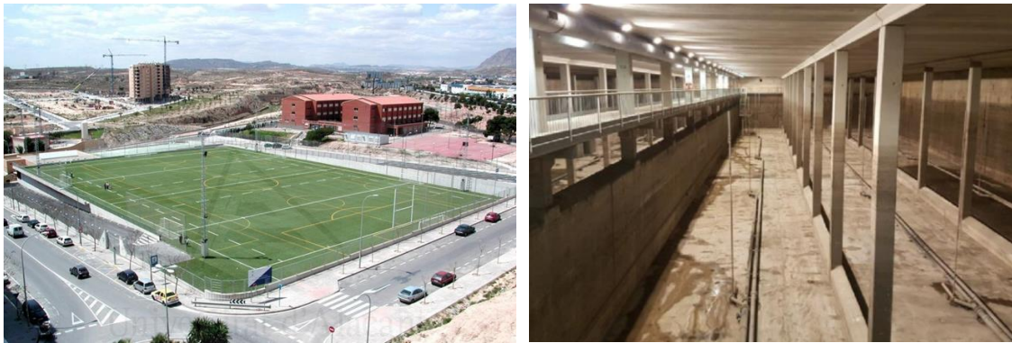
Ilustración 27 Polideportivo arriba y la interna del depósito anticontaminación debajo Fuente: Ferreira, 2019.
