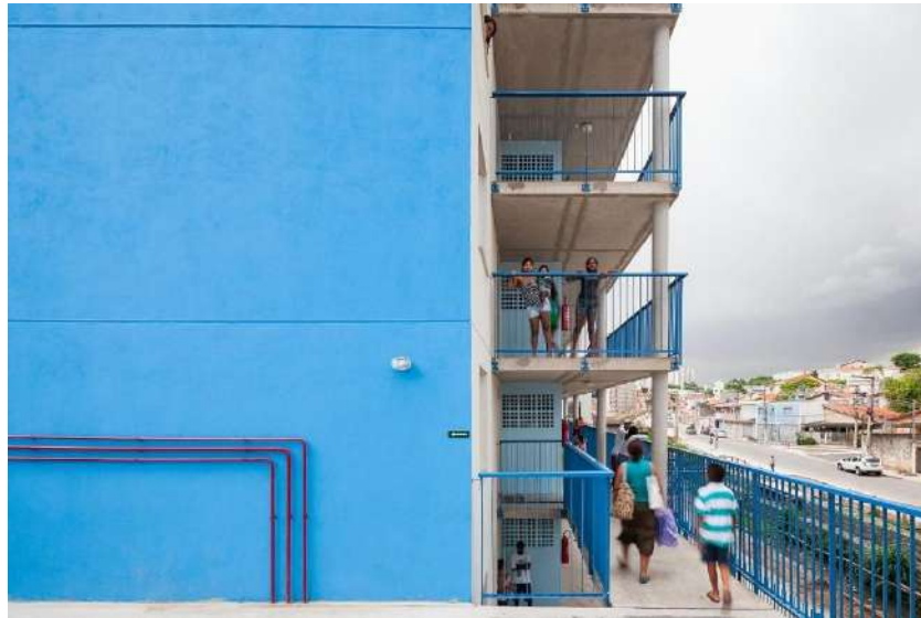
Imagen: Balcones del edificio.
