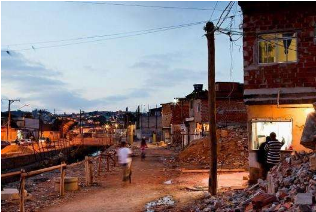
Imagen: El barrio durante la ejecución del proyecto.
