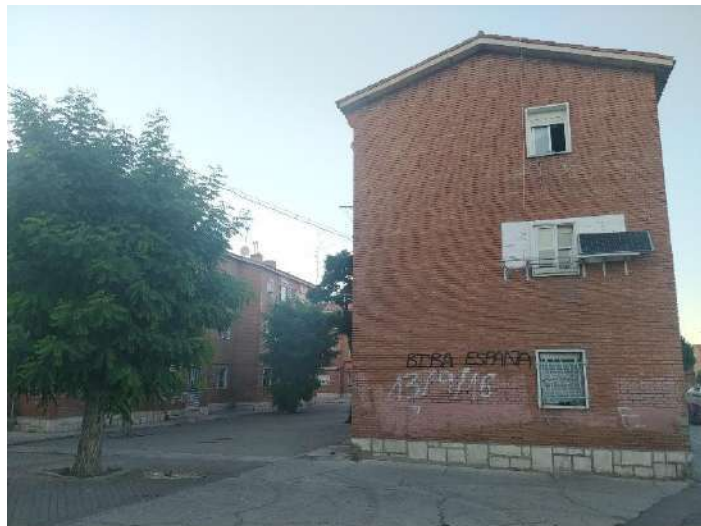
Imagen: Foto del edificio con el panel solar en la fachada.
