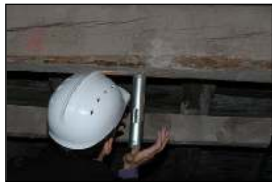
Fig. 7. Aplicación en obra del pilodyn.
