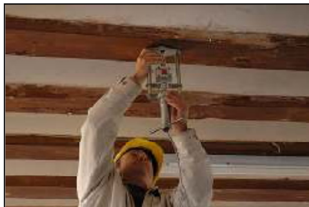
Fig. 11. Aplicación en obra del extractor de tornillos.
