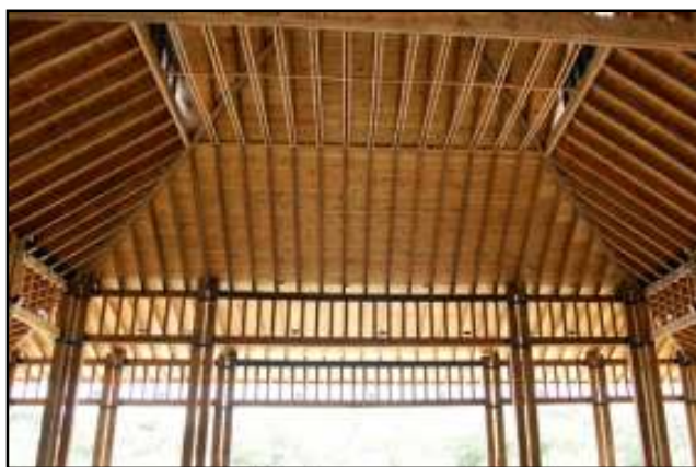
Fig. 6. Entramado del forjado de madera
