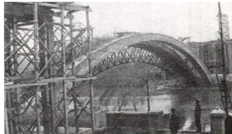
Fotografía 4. Puente Isabel la Católica durante su construcción.
