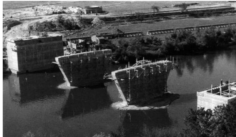
Fotografía 3. Puente Adolfo Suárez durante su construcción.
