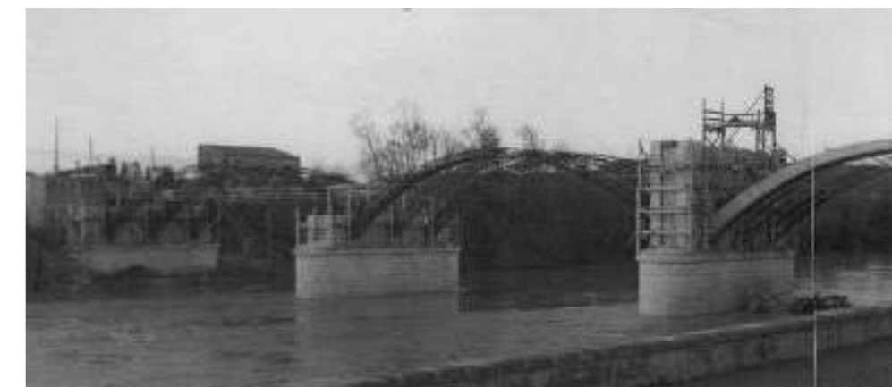
Fotografía 5. Puente del Poniente durante su construcción.
