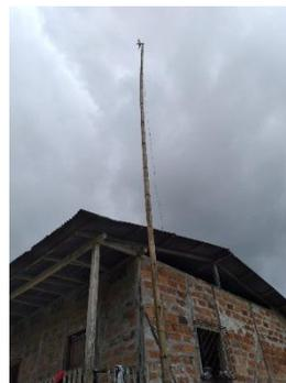
Imagen 115 – Utilización de caña guadua para instalar una antena de aire para Tv.
