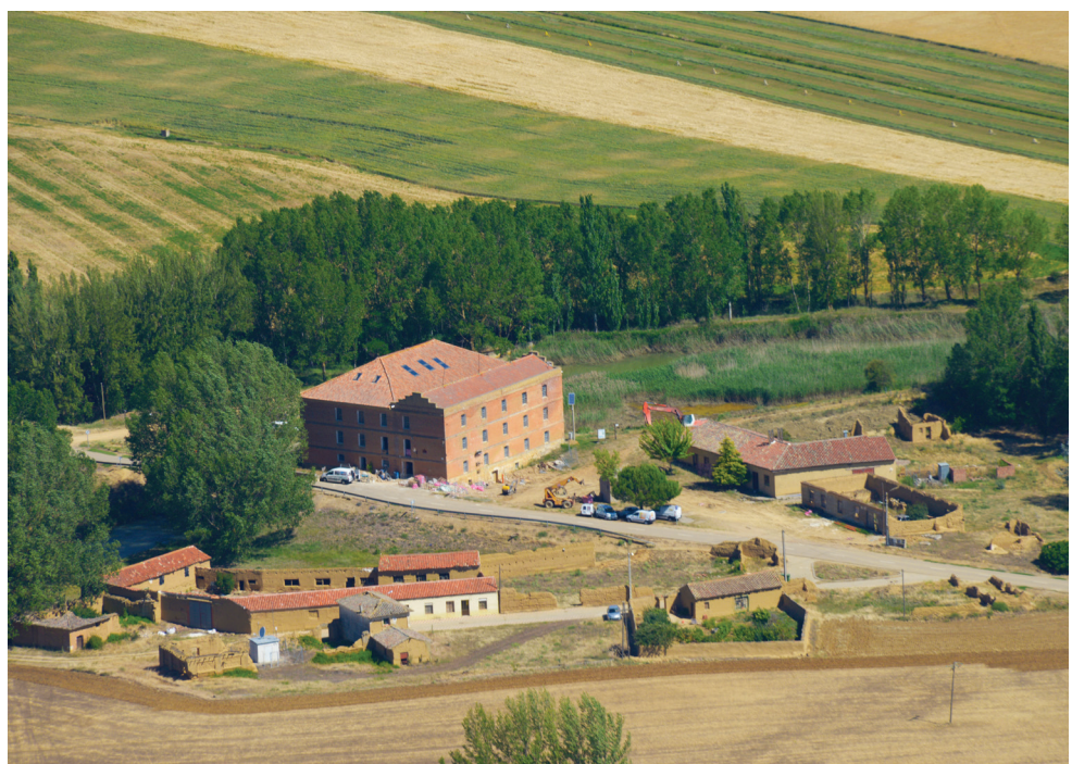
Figura 7. Fábrica de Harinas de Abarca de Campos, en proceso de rehabilitación. (Foto: E. Baraja, 18/06/2015).
