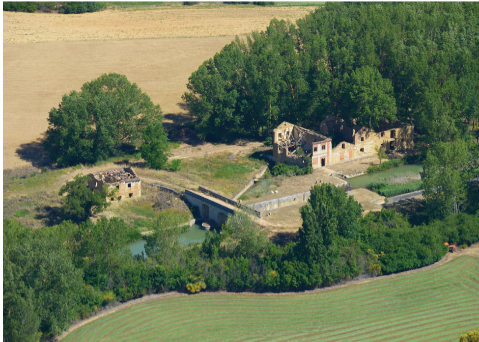
Figura 5. Infraestructuras del Canal en ruinas, en Capillas (Palencia). (Foto: E. Baraja, 18/06/2015).
