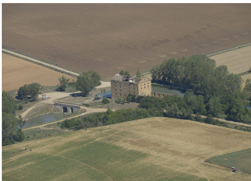
Figura 4. Harinera en ruinas. Tamariz de Campos. (Foto: E. Baraja, 18/06/2015).
