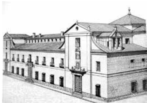
Visión General de la estructura del Hospital
