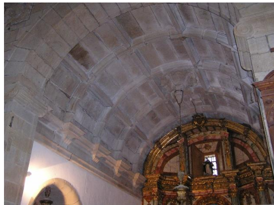
Fig. 13. Bóveda de cañón casetonada de una capilla lateral de la iglesia de San Martín Pinario de Santiago de Compostela. Finales del siglo XVI. Foto de la autora
