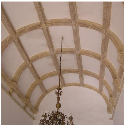
Fig. 12. Bóveda de cañón casetonada de la portería actual del monasterio de San Julián de Samos. Segunda mitad del siglo XVIII. Foto de la autora
