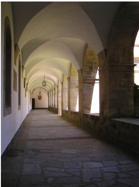
Fig. 2. Bóvedas de arista sobre las galerías del claustro grande. Foto de la autora
