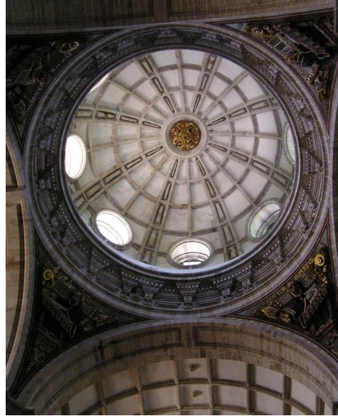
Fig. 9. Cúpula casetonada sobre el espacio central del crucero de la iglesia de San Julián de Samos. Medios del siglo XVIII.
