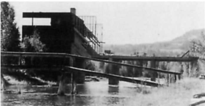
Fig 12: La White Cabin , en la que se aprecia el tercer piso
