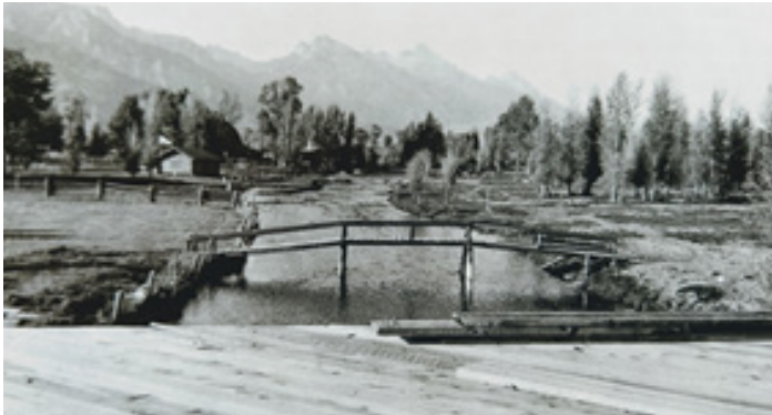
Fig 10: Vista desde la plataforma de madera levantada sobre el arroyo
