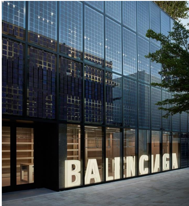
Fuente: Onyx Solar. Muro cortina de la tienda perteneciente a la firma Balenciaga en Miami
