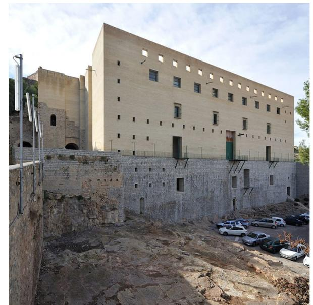
Fig 47- 48. *Frons scaenae* y *postscenium* tras la intervención. Se observan los dos niveles de materiales empleados.
