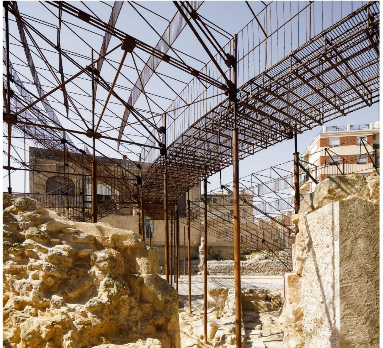
Fig 96. Fotografía de la estructura de varillas de acero corrugado (2019).
