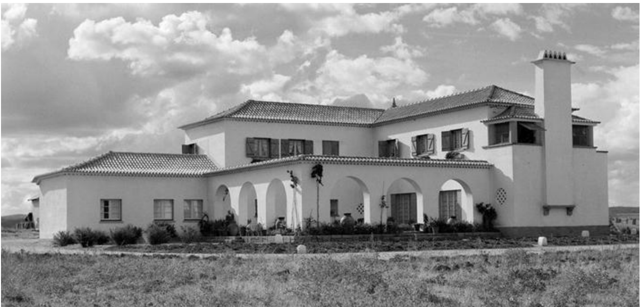
Fig. 53 Exterior del complejo
