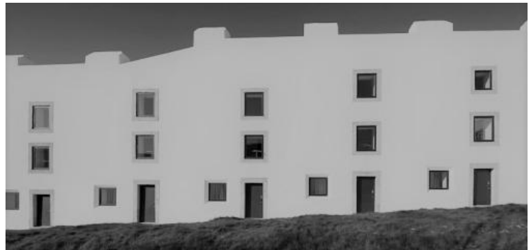
Fig. 11 Hotel Ciudadela en Cascais, Gonçalo Byrne (2012)
