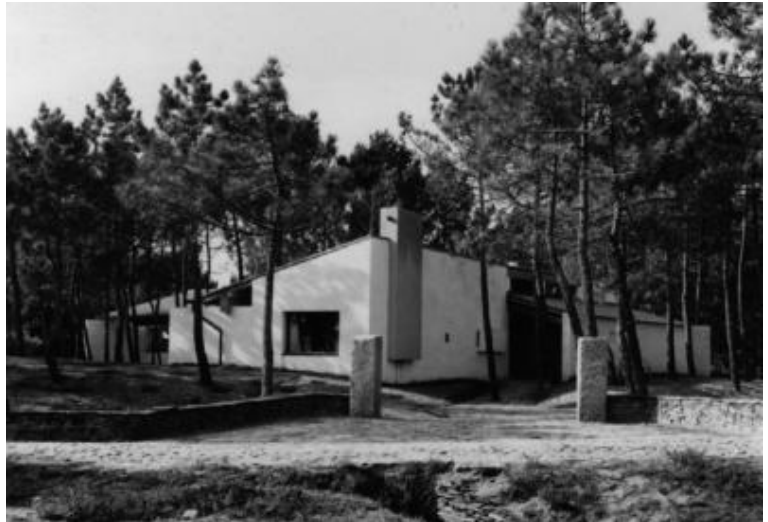
Fig. 07 Casa Ofir en Oporto, Fernando Távora (1957)
