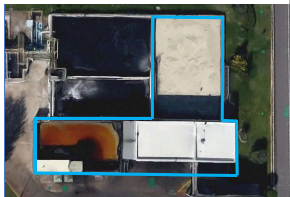
Ilustración 5. Actual Terminal de Vertidos
