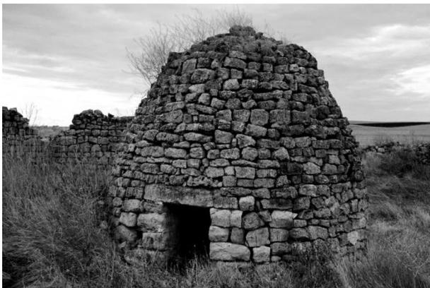
Ilustración 13: Chozo de pastor, cuadrados o circulares, realizados con mampostería de piedra seca, cuyas cubiertas se levantan aproximando las piezas hasta que cierran la bóveda, pudiendo incluso dotarse con la anexión de un volumen más pequeño, para cobijo del pozo.
