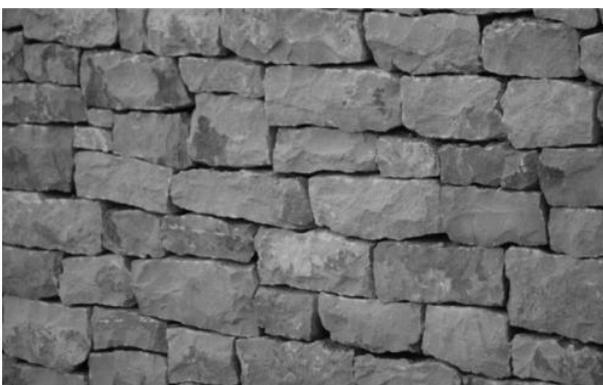
Mampostería concertada: es aquella técnica en la que los mampuestos, rudamente labrados y seleccionados por su forma poligonal, son colocados de manera que sus caras estén juntas. La piedra, queda asentada o calzada mediante ripios o piedras pequeñas que, encajadas entre los huecos de los mampuestos, logran mayor estabilidad y firmeza en el cuajado de la fábrica.
