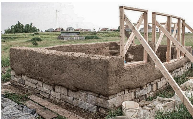
Ilustración 9: muro con sistema Cob en proceso
