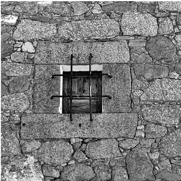
*Ilustración 10: Mampostería de granito; piedra entera en vanos y esquinales de ventanas y huecos.*
