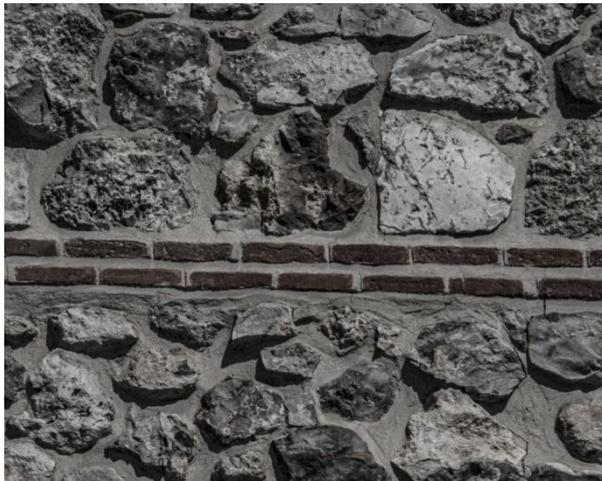
Mampostería con verdugada: es aquel muro que cada cierta altura se ejecuta una verdugada de ladrillo macizo que regulariza horizontalmente cada tramo. Generalmente, las hiladas de mampuesto se realizaban con piedras irregulares, de diferentes tamaños y estabilizados mediante algún tipo de mortero.
