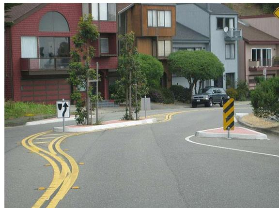
FIGURA 14. Desvío del eje de ambos carriles
