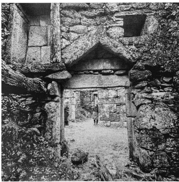
Figura 23: Hueco para puerta con arco de descarga
