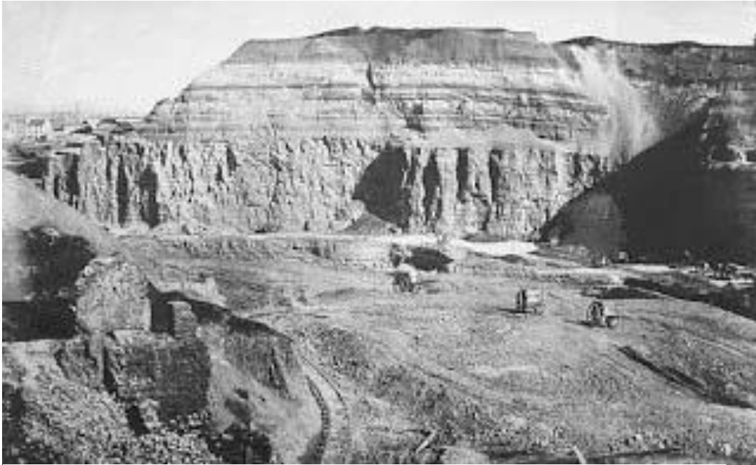
Fig. 8 Imagen del estado de la cantera antes de la construcción del Buttes-Chaumont
