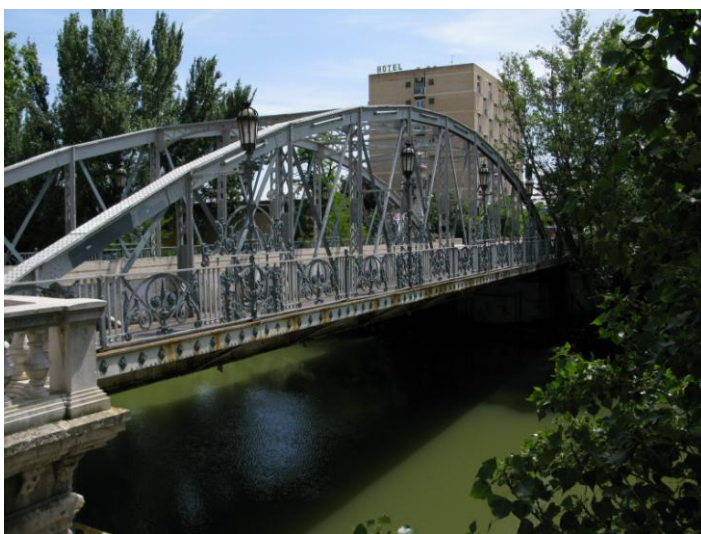
Figura 42: Puente colgante. Valladolid.
