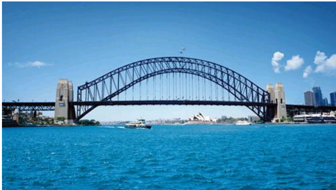
Figura 41: Puente bahía de de Sidney. Australia
