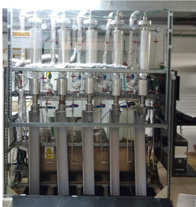
Figura 9 Planta piloto donde se llevó a cabo la extracción
