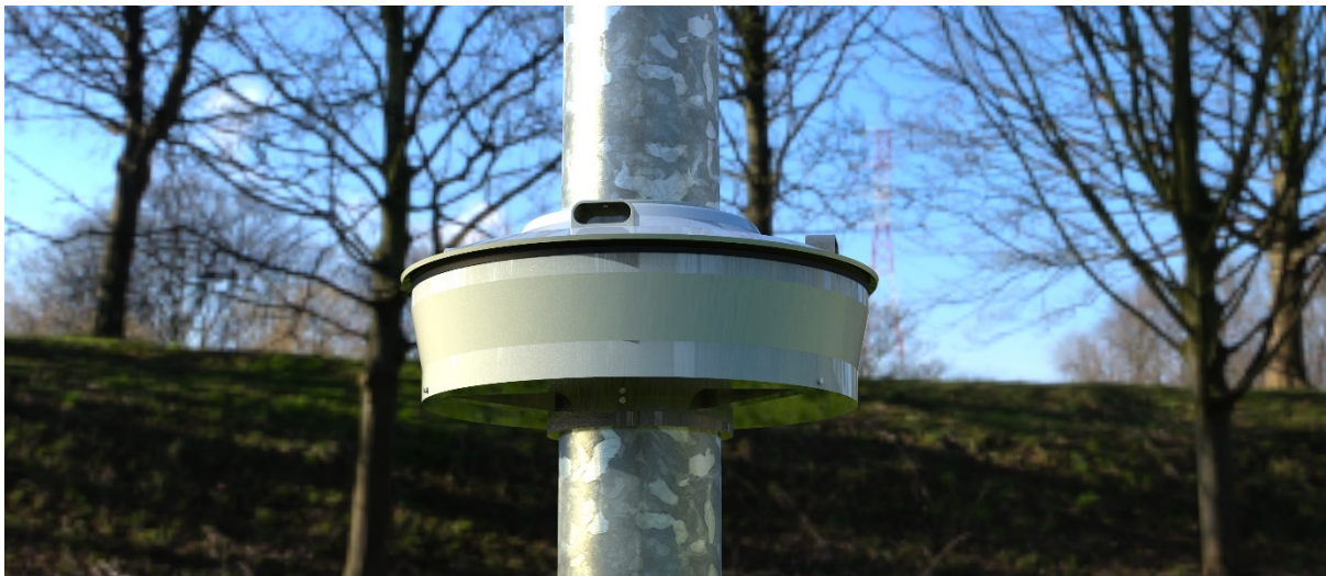
Imagen 151: Montaje parte 13 Fuente: Propia
