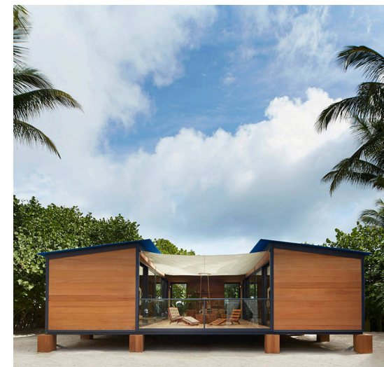
4.110_Construcción para la muestra Design Miami 2014
