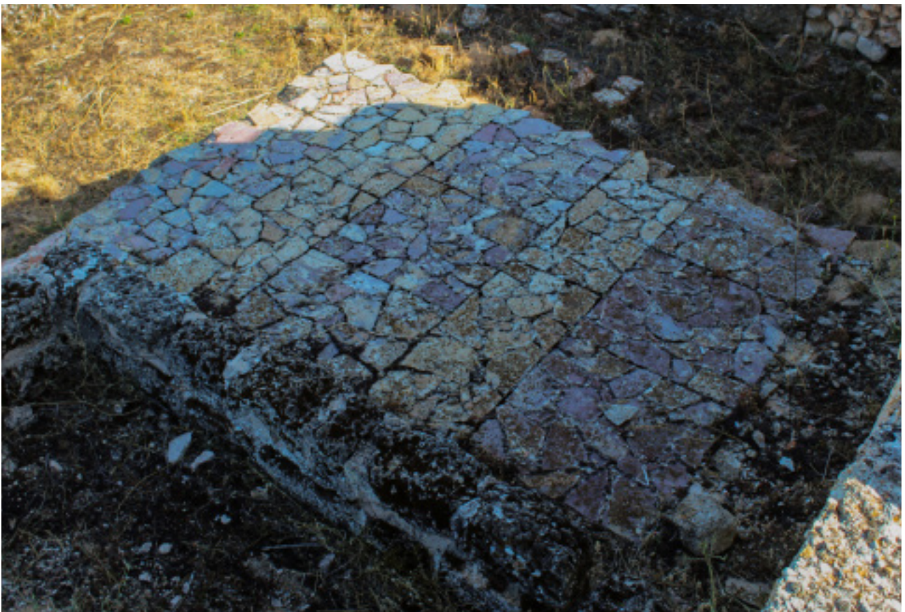
Fig. 109: restos del pavimento de Opus Sectile del tepidarium este de las termas “Los Arcos I”.
