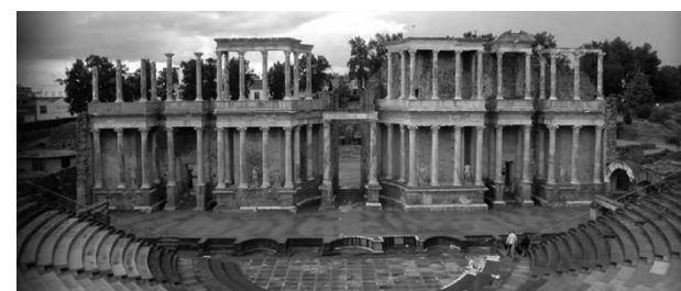
Imagen 29. Proceso de anastilosis realizado en el teatro romano de Mérida. Fotos recuperadas de La Scaenae Frons del teatro romano de Mérida de Pedro Mateos Cruz.
