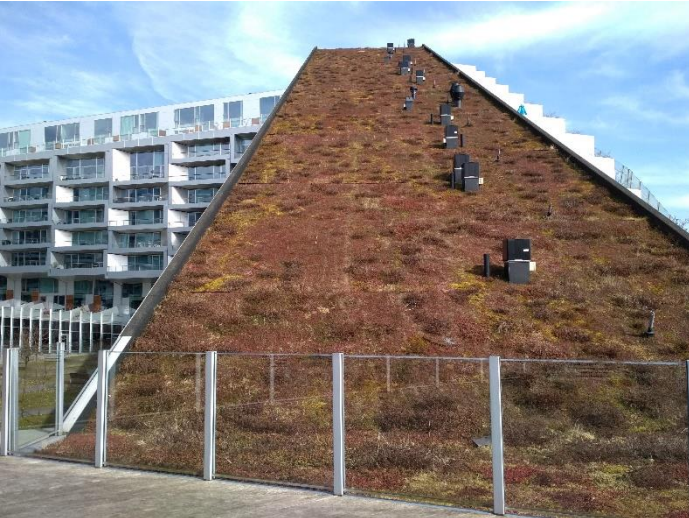
↑ Imagen 67. Cubierta vegetal extensiva en The Eight House , en Orestad, Copenhagen.
