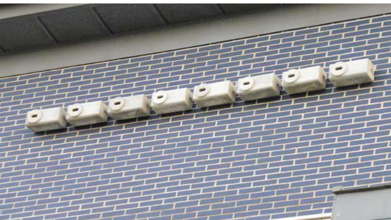
←Imagen 74. Nidales para vencejo común instalados en el instituto Física de Cantabria, tras una remodelación.
