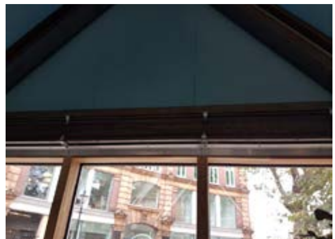
Imagen 53: Unión de abrazadera entre perfiles de acero de la estructura y el acristalamiento. "The Circular Building". Fuente: Lindapter, página web: http://www.lindapter.com/Case_Studies/Arups_Circular_Building
