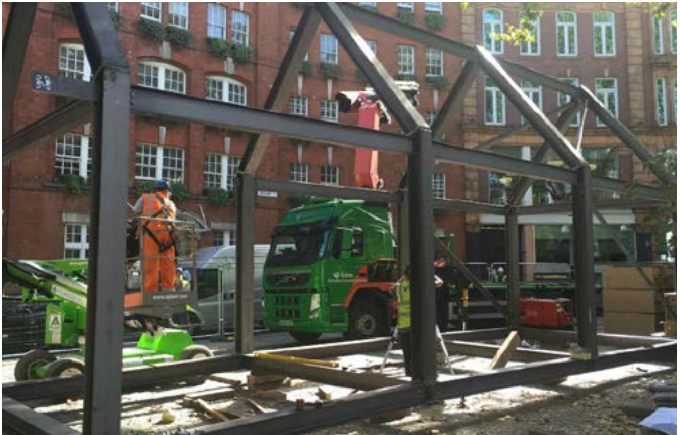
Imagen 51: Construcción de la estructura de acero de "The Circular Building". Fuente: BAM, página web: https://www.bam.co.uk/media-centre/news-details/bam-opens-circular-building-at-london-design-festival
