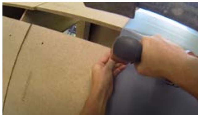
Imagen 64: Colocación lámina impermeable Fatra. Fuente: Recorte vídeo "The Circular Building-A learning journey" https://www.youtube.com/watch?v=s03dNDg_hWQ&t=6s
