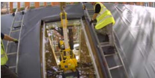
Imagen 69: Colocación tragaluz VELUX VMS en "The Circular Building". Fuente: Recorte vídeo de la construcción de The Circular Building-A learning journey.
