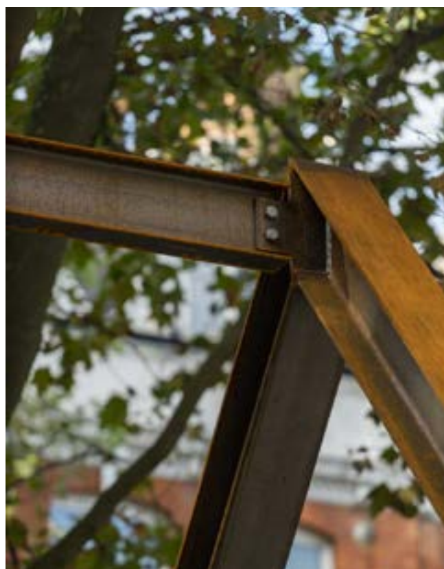
Imagen 50: Unión atornillada entre perfiles de acero de la estructura de "The Circular Building". Fuente: http://www.arquitecturaenacero.org/proyectos/edificios-de-equipamiento-y-servicios-vivienda-unifamiliar/circular-building
