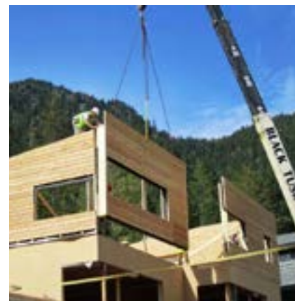
Imagen 33: Construcción prefabricada. Fuente: http://maderayconstruccion.com.ar/europa-boom-las-casas-prefabricadas-pasivas-futu-
