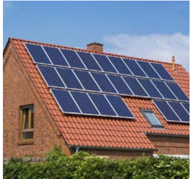
Imagen 13: Instalación de paneles fotovoltaicos en una casa. Estrategia Activa. Fuente: https://www.tynmagazine.com/energia-solar-una-solucion-al-alcance-de-la-mano/
