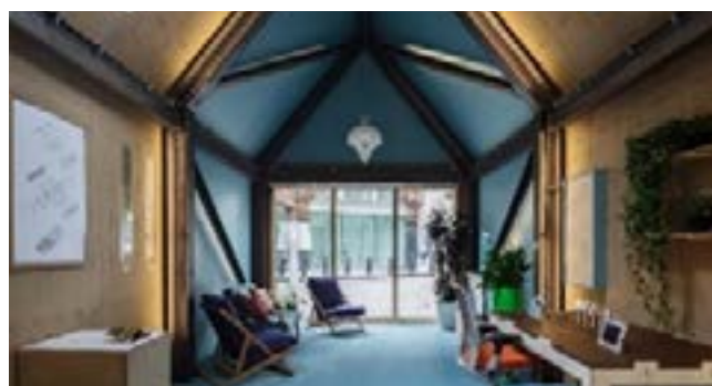
Imagen 79: Acabado interior "The Circular Building": tela acústica azul AUTEX. Fuente: http://www.arquitecturaenacero.org/
