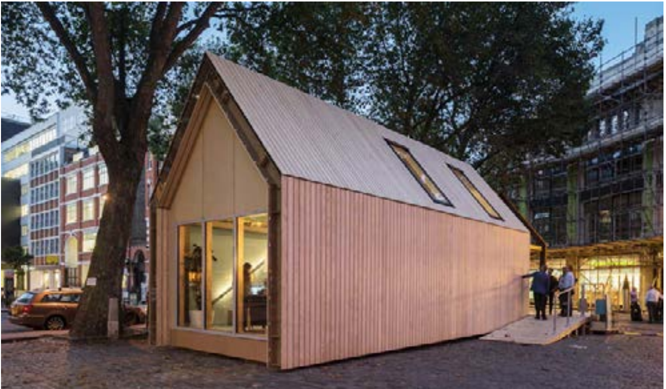
Imagen 58: Vista exterior de "The Circular Building". Revestimiento de madera del fabricante Accoya. Fuente: http://www.arquitecturaenacero.org/proyectos/edificios-de-equipamiento-y-servicios-vivienda-unifamiliar/circular-building
