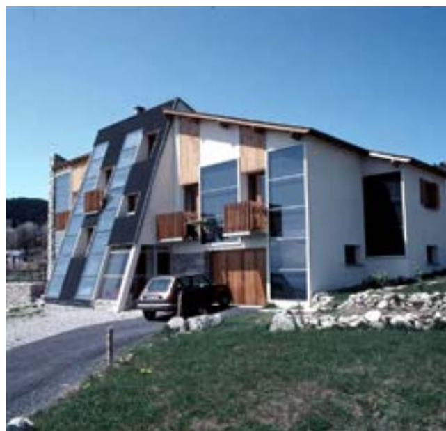
Imagen 15: Ejemplo muros captadores. Estrategia pasiva. Fuente: https://huellasdearquitectura.wordpress.com/2018/10/22/muros-trombe-que-son-y-como-funcionan/
