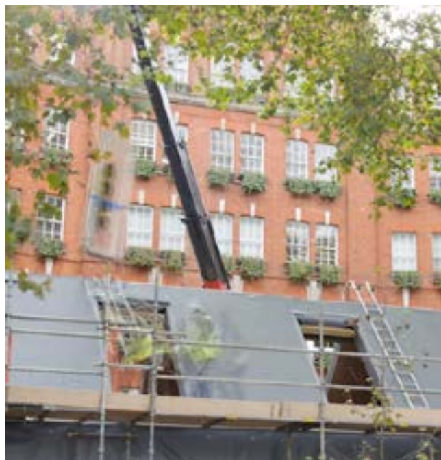
Imagen 70: Desmontaje tragaluz VELUX VMS en "The Circular Building". Fuente: Recorte vídeo de la construcción de The Circular Building-A learning journey.
