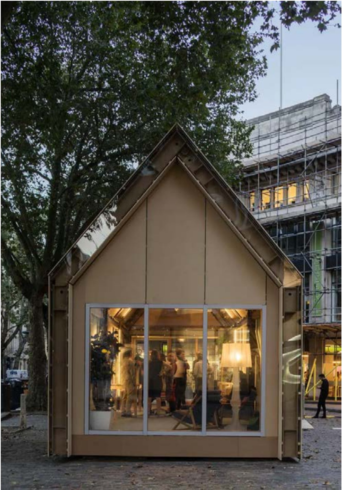
Imagen 42: Fachada trasera de The Circular Building, donde se pueden percibir las capas del edificio. Fuente: https://archinect.com/aruparchitects/project/the-circular-building
