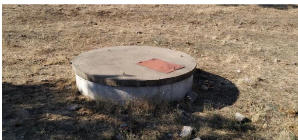
Pozo de la parcela y motobomba de gasolina
