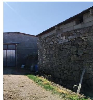
Muro de piedra Fuente: propia
