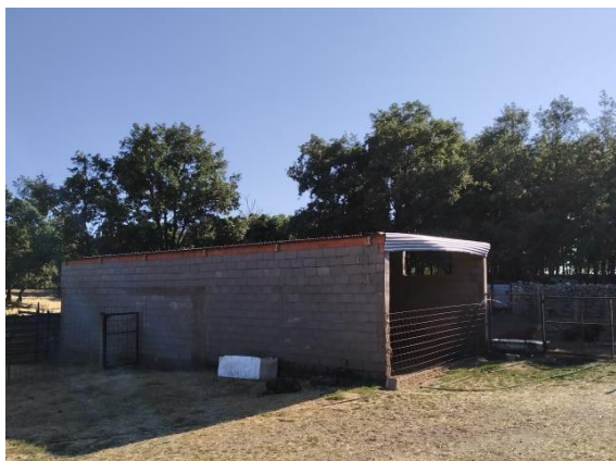
Nave para ovejas: visión lateral e interior
