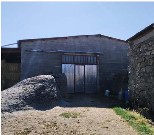
Nave: acceso principal e interior
