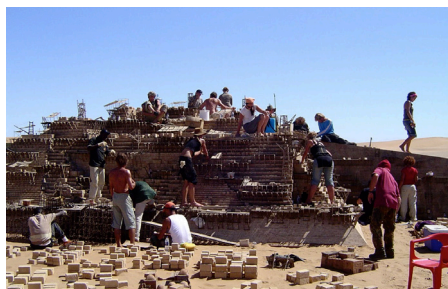
Fig. 550 Maqueta en construcción
