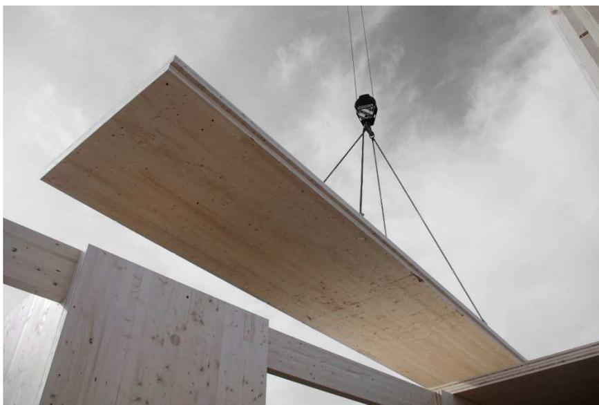
Fig. 47 Colocación en obra de un panel CLT.
