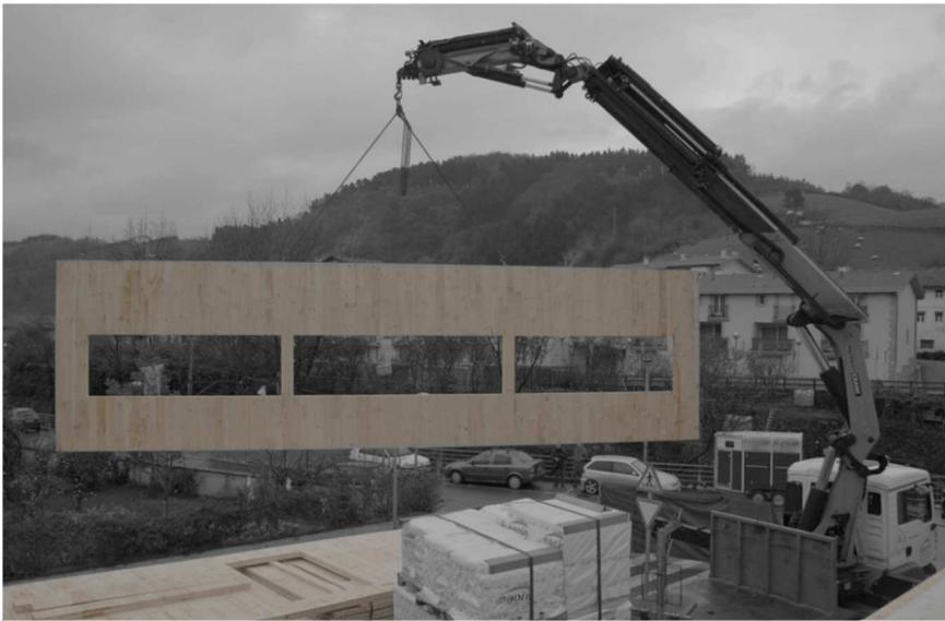
Fig. 54 Puesta en obra de los paneles CLT.
