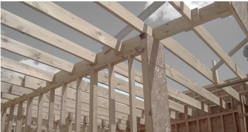
Fig. 42 Sistema constructivo de entramado ligero de madera.
