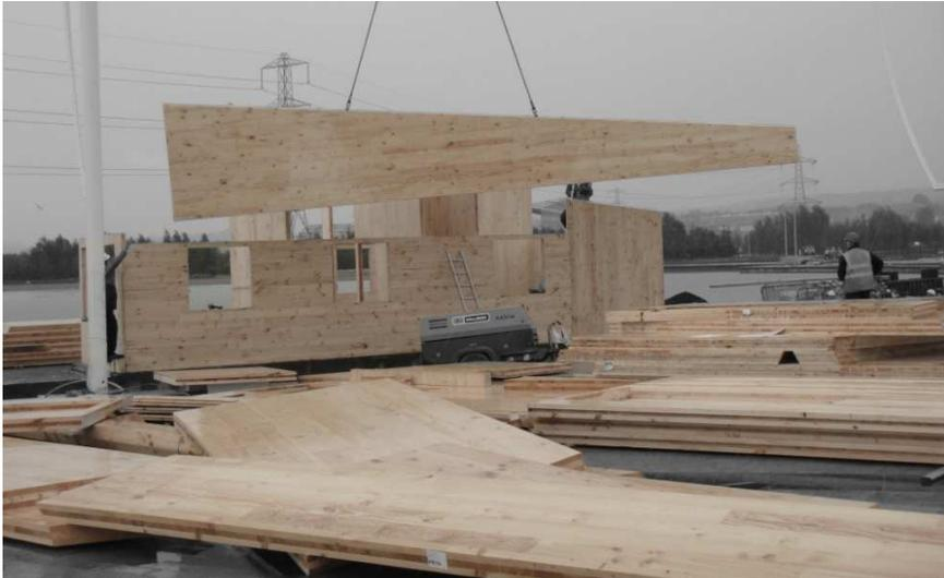
Fig. 53 Puesta en obra de los paneles CLT.
