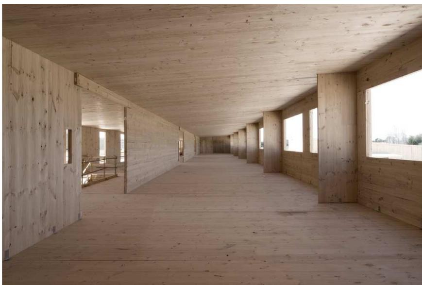
Fig. 52 Obra realizada con paneles CLT en forjados y muros.
