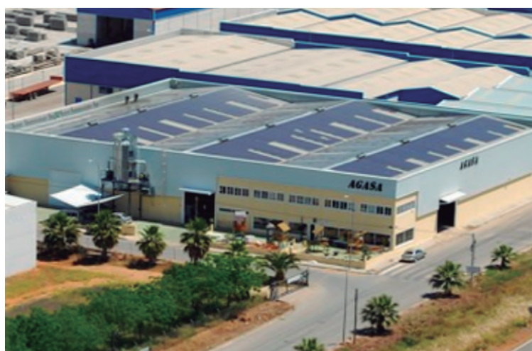
Figura 5.3: Vista superior del techo de la planta industrial de Agasa S.L. [ http://www.agasasl.com/quienes_somos.php ]
