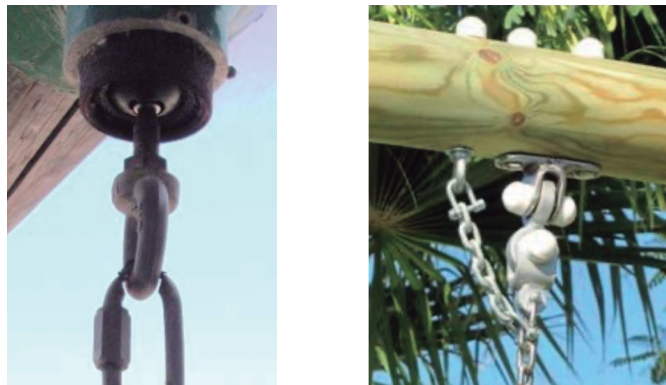
Figuras 5.12 y Figura 5.13: Cadena de seguridad en uniones de cadena y viga. Agasa S.L
