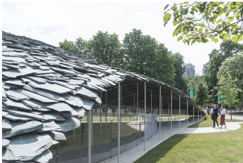
Detalle cubierta de pizarra del Serpentine Pavilion 2019, Junya Ishigami © Laurian Ghinitoiu
