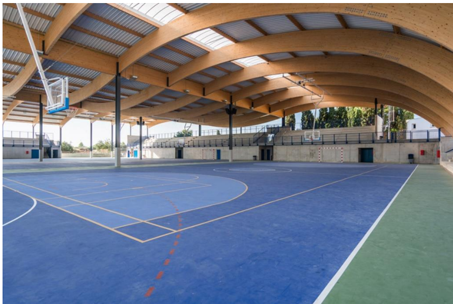
Figura 2. Estructura madera laminada. Polideportivo Madre Alberta (Mallorca)
