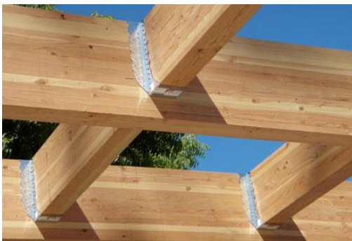
Figura 22. Placas auxiliares vistas. https://www.maderea.es/uniones-y-ensamblajes-con-madera/
