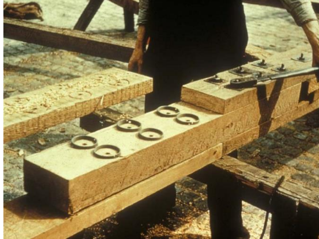
Figura 16. . Colocación de los anillos de conexión. https://www.unav.edu/departamento/bcp/picturesMadUniMec02.html
