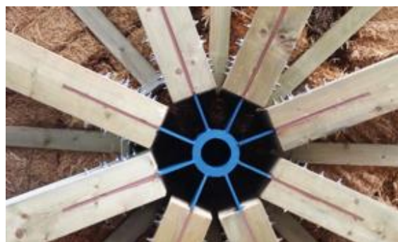
Figura 21. Placas auxiliares ocultas https://www.maderea.es/uniones-y-ensamblajes-con-madera/
