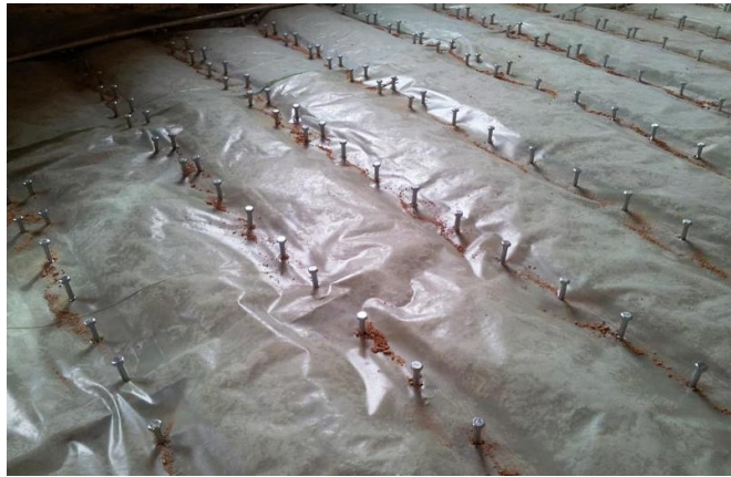
Figura 64. Refuerzo de un forjado de madera.
