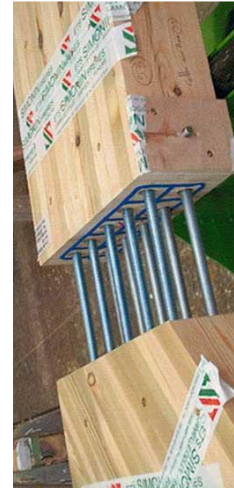
Figura 19. Unión mediante barras roscadas encoladas. https://tectonica.archi/materials/union-de-madera-laminada-mediante-varillas-de-acero-encoladas/
