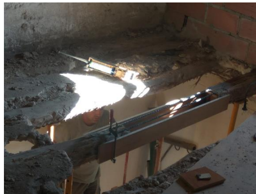
Figura 50. Intervención en viga de madera con sistema Beta. http://sofcar.es/portfolio/repuracion-de-vigas-de-madera-con-sistema-beta/
