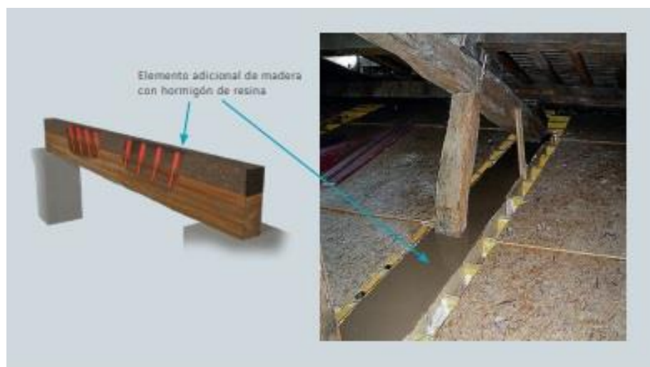
Figura 59. Reconstrucción de la parte superior de una viga con mortero epoxi.
