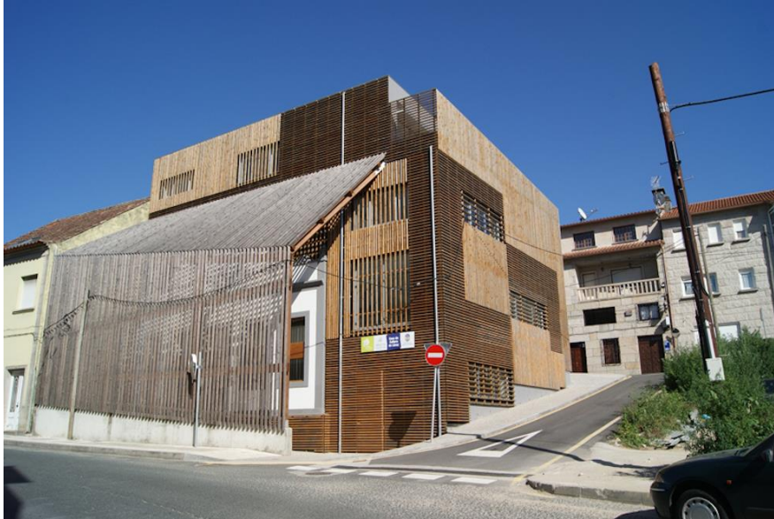
Figura 31. Centro Cultural de Lérez. Arquitectos Jorge Rodríguez+José María Soto. https://maderayconstruccion.com/madera-modificada/
