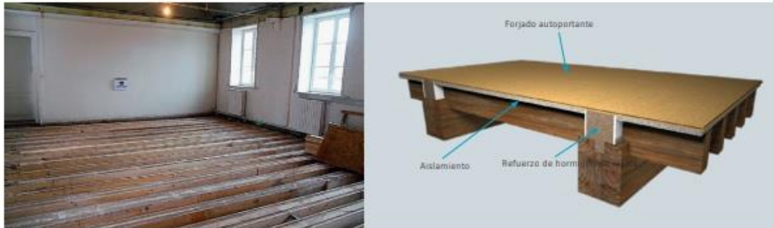
Figura 62. Refuerzo de forjado autoportante.
