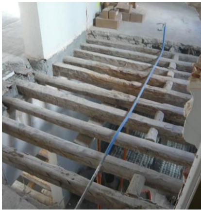
Figura 63. Refuerzo de un forjado de madera.
