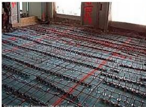
Figura 65. Refuerzo de un forjado de madera.
