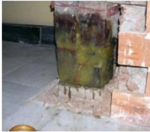
Figura 66. Calzado de un pie derecho con resina epoxi. http://oa.upm.es/53437/1/L032009TCXIMadera.pdf
