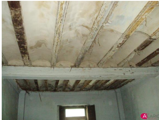
Figura 40. Apeo permanente transversal. https://enriquealario.com/refuerzo-de-forjados-de-madera-por-la-cara-superior/#lightbox/3/
