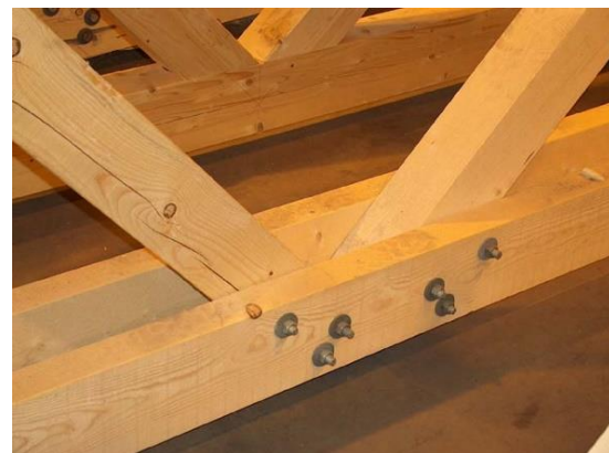
Figura 13. Unión mecánica mediante pernos. https://www.unav.edu/departamento/bcp/picturesMadUniMec02.html
