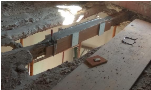
Figura 52. Intervención en viga de madera con sistema Beta. http://sofcar.es/portfolio/repuracion-de-vigas-de-madera-con-sistema-beta/
