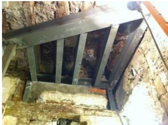
Figura 41. Apeo diagonal. https://serviref.es/refuerzos-en-estructura-de-madera-con-hierro-y-sistema-beta/
