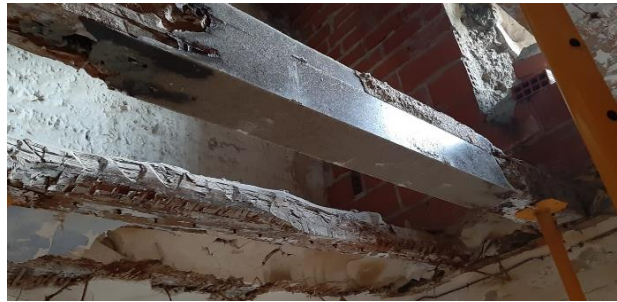
. Figura 51. Intervención en viga de madera con sistema Beta. http://sofcar.es/portfolio/repuracion-de-vigas-de-madera-con-sistema-beta/
