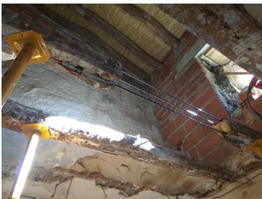
Figura 49. Intervención en viga de madera con sistema Beta. http://sofcar.es/portfolio/repuracion-de-vigas-de-madera-con-sistema-beta/
