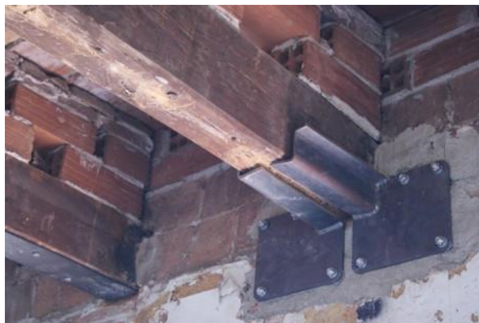
Figura 44. Refuerzo con perfil metálico. https://itearquitectes.com/2018/09/24/estructuras-de-madera-iii-iii-las-deficiencias-y-su-reparacion/refuerzo-viga-madera-2/
