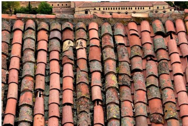
Fig.79: Roturas y desaparición de tejas (silencioarquitectos, 2017)
