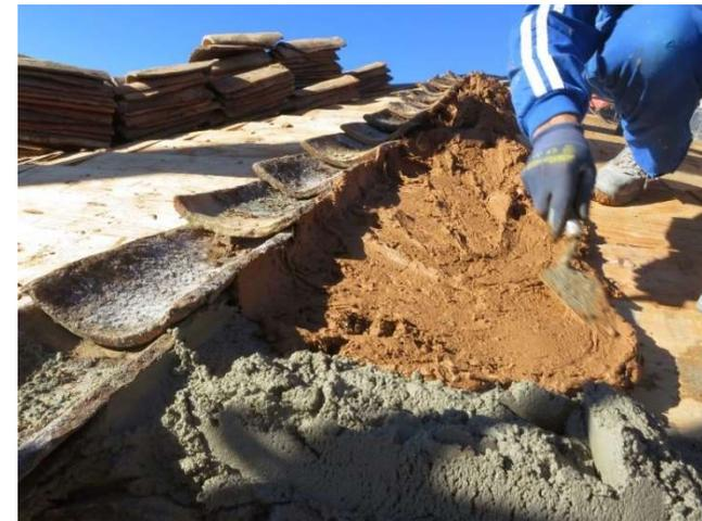
Fig.86: Mortero de barro y paja para recibir tejas canal (El Talón Sierte, 2014)
