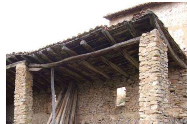
Fig.81: Viga rolliza flectada (Vegas & Mileto, 2007)
