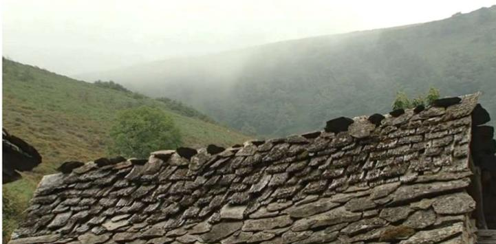
Fig.8: Cubierta de chillas y losas (G.D.R. Alto Narcea Muniellos, 2011)
