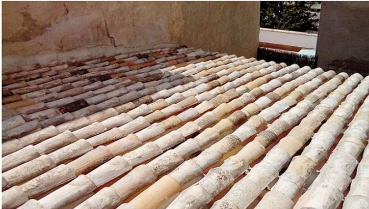
Fig.4: Cubierta de teja árabe colocación clásica (Baluarte,2017)
