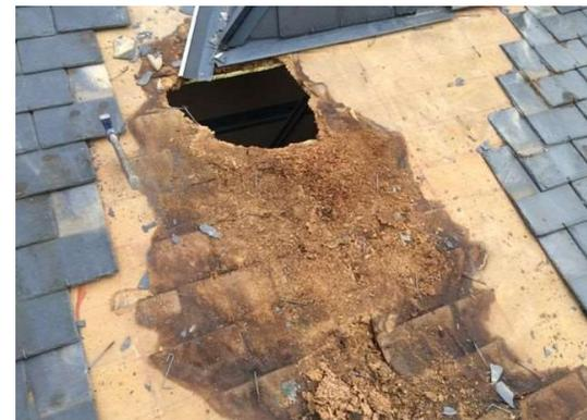
Fig.72: Daños en tablero por filtración (Tejados San José, 2016)
