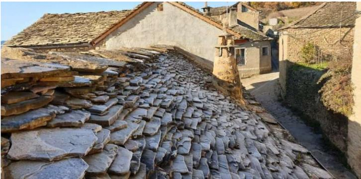
Fig.6: Cubierta de losas a granel (Os piqueros de Soduroel, s.f.)
