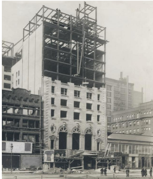
Figura 11. Edificio en construcción en Chicago
