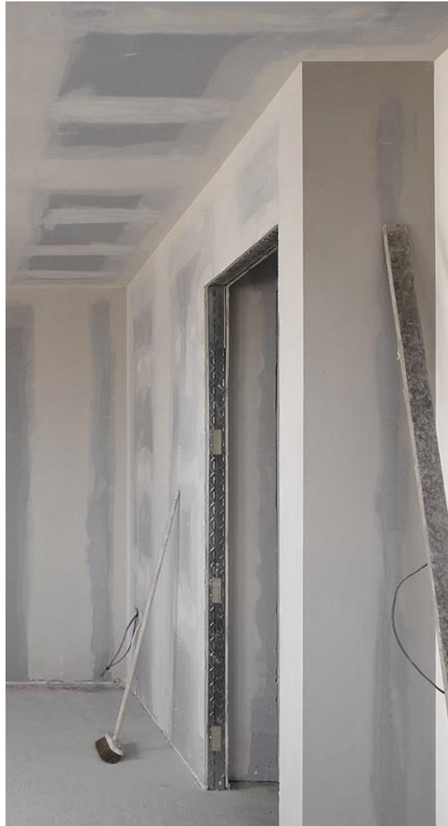
Figura 118. Interior revestido con placas carton-yeso Stadthaus
