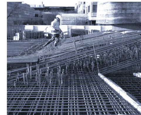
Fig. 120: Imagen aérea del proceso de construcción del "EPFL Rolex Learning Center", SANAA (2010)
