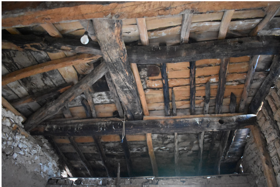
Armazón de cubierta formado en su totalidad con maderas de diferentes especies vegetales. Fuente: Elebaración propia.
