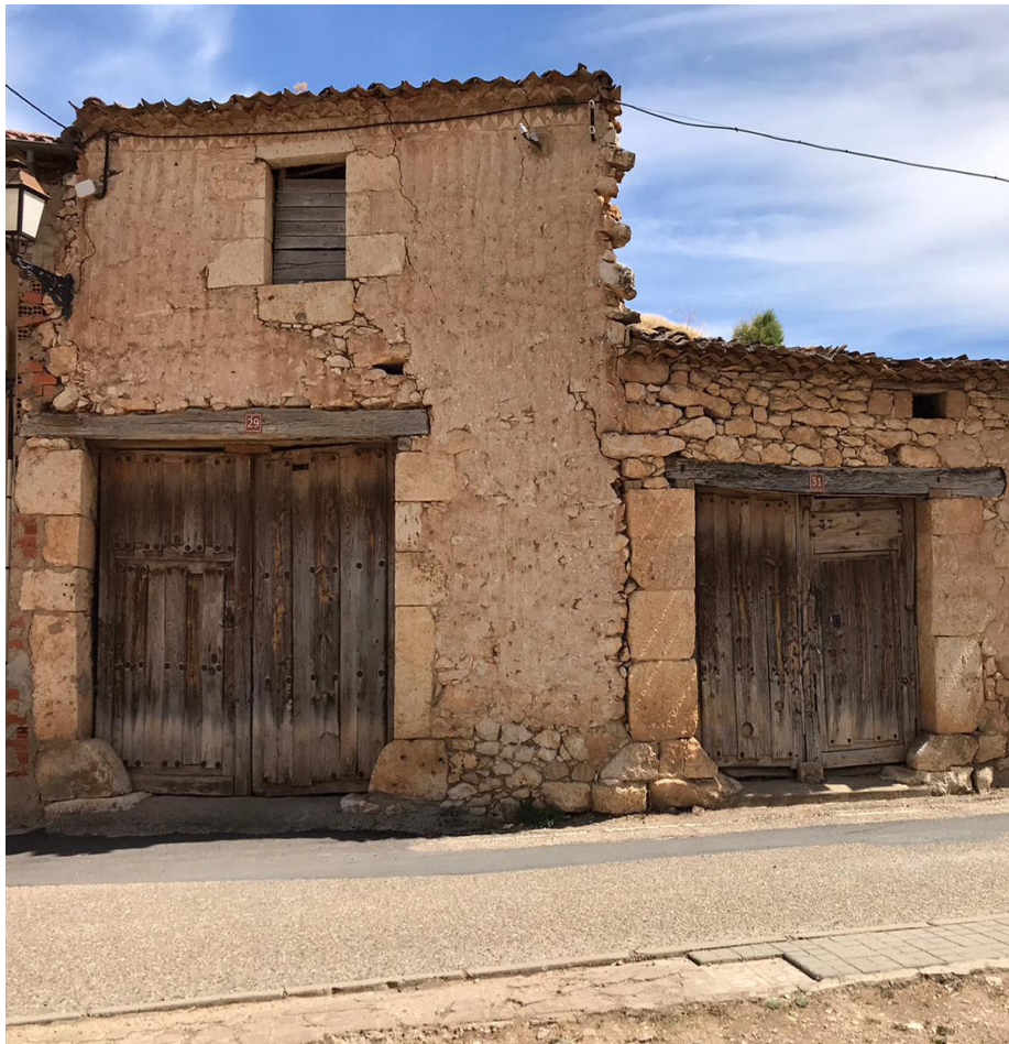
Guardacarrros y corral, puertas carreteras de madera, con pequeños herrajes metálicos. Fábricas de mampostería irregular excepto esquinas y vanos, combinado con dinteles de madera Fuente: Elebaración propia.
