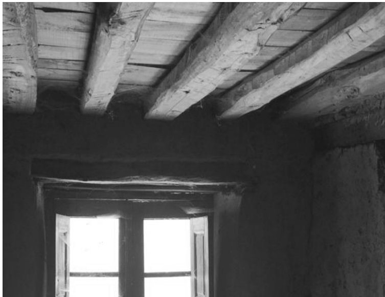
Encuentro de viguetas con muro de carga y vano de ventanal.
