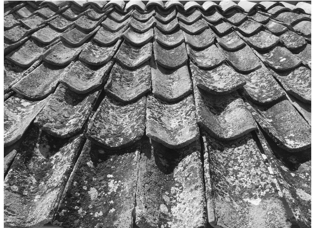
Imagen exterior, estado actual. Cubierta, disposición a canal de teja árabe. Fuente: Elaboración propia.
