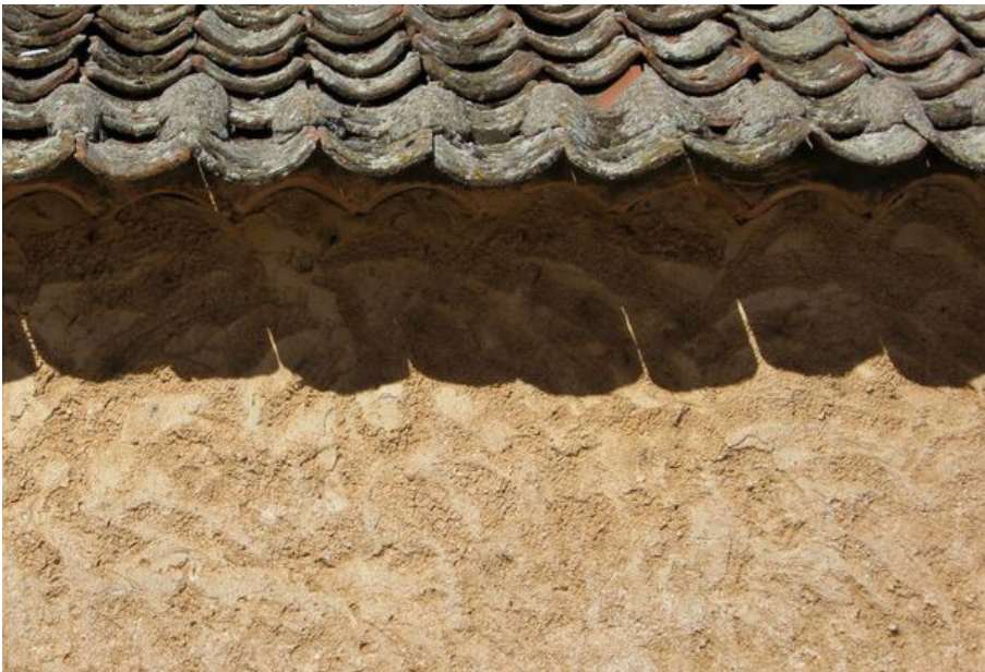
Trullado de tierra como protección y mantenimiento de la fábrica por su exterior. Fuente: Centro de Investigación de Arquitectura Tradicional de Boceguillas.
