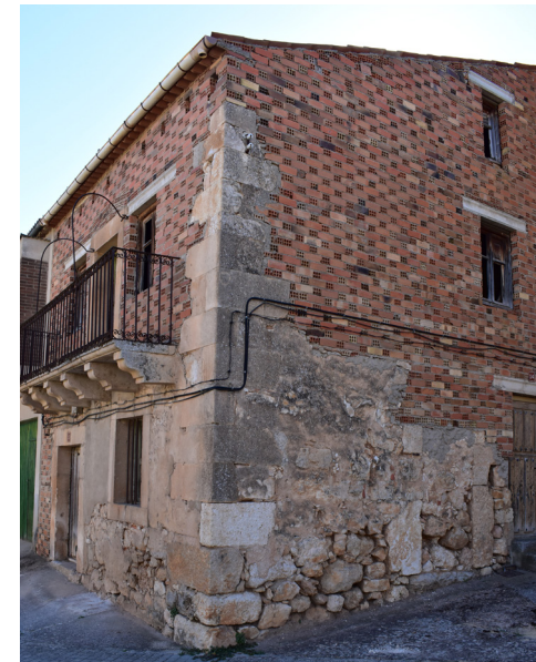
Ejemplo de erróneas intervenciones constructivas, que se han llevado a cabo en los últimos años, con materiales modernos que chocan con las técnicas tradicionales, normalmente por desconocimiento y facilidad de medios. Ejemplo de mala praxis rehabilitatoria. Fuente: elaboración propia
