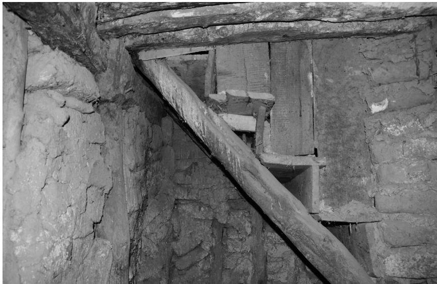
Encuentro de escalera con viga de carga y pie derecho.
