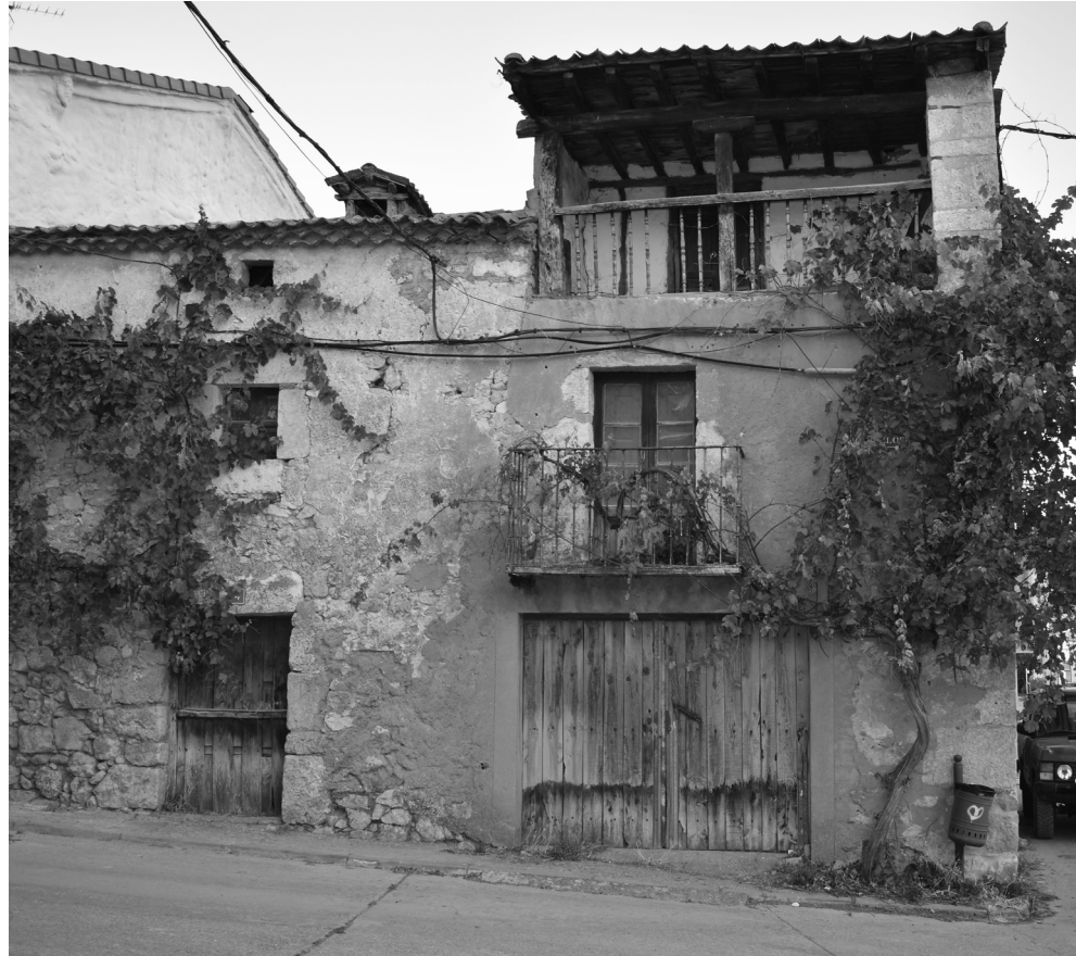
Situación actual de la vivienda, con la modificación en los años 80 de una gran apertura para el paso de coches. Huevo que será aprovechada en proyecto.
