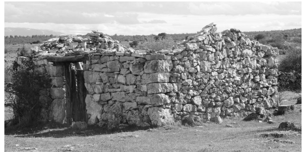
Imagen de una antiguo edificio de uso agrícola o ganadero. Fuente: www.ciat.es patrimonio cultural.
