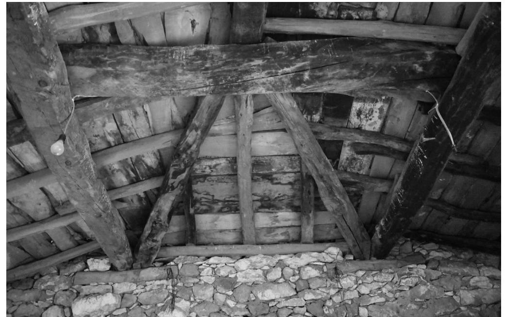
Conformación de armazón de cubierta. Encuentro de vigas, cargaderos y viguetas.
