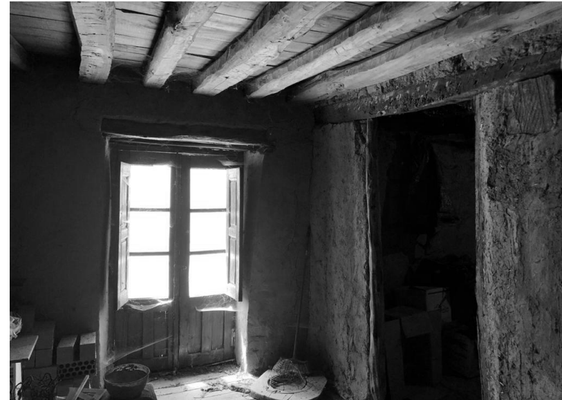
Imagen interior, estado actual. Planta primera, sala de estar.
