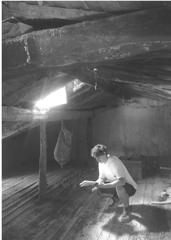
Fotografía del proceso de levantamiento, observación, toma de medidas y análisis del estado del edificio.
