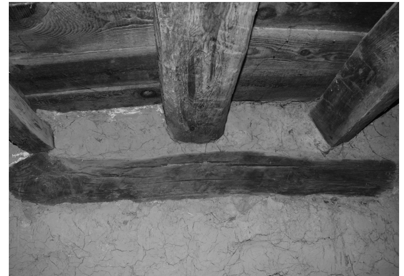
Encuentro de viguetas con muro de carga de mampostería perimetral.
