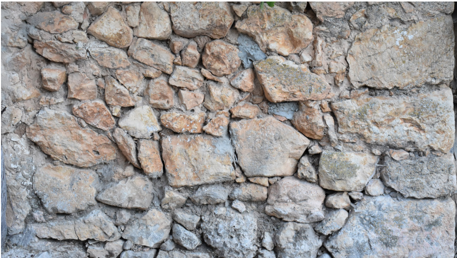
Trullado de tierra como protección y mantenimiento de la fábrica por su exterior. Fuente: Centro de Investigación de Arquitectura Tradicional de Boceguillas.
