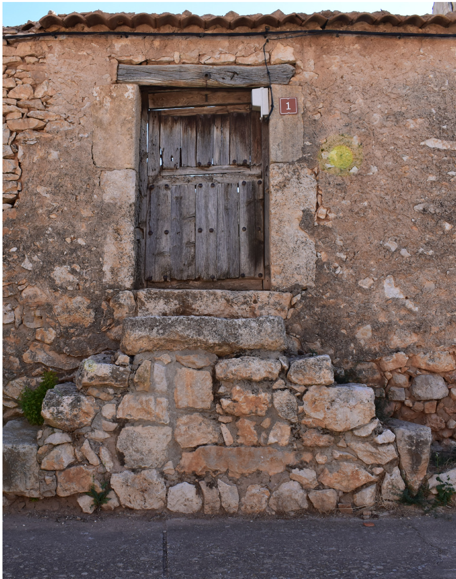
Uso de la piedra como principal elemento constructivo. Como mampuesto o sillar labrado, conformando escalinata de acceso y fábrica. Fuente: Elaboración propia.
