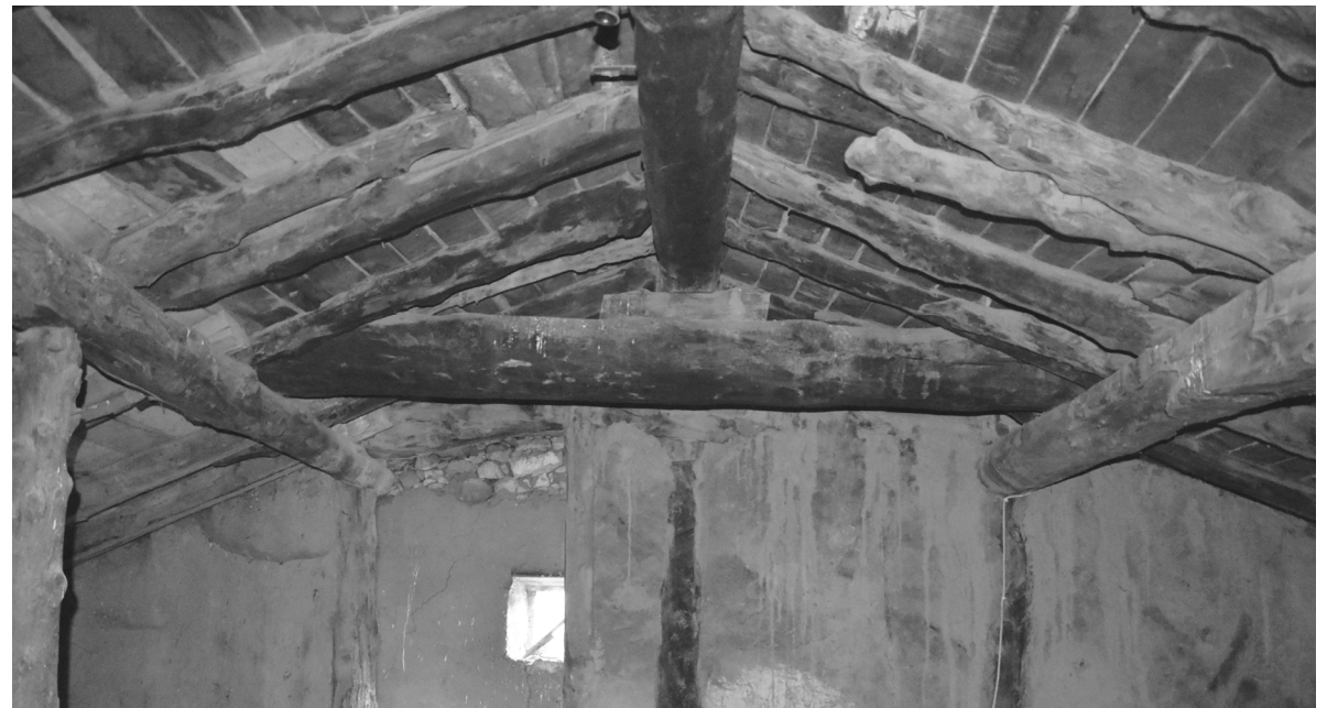
Disposición de vigas de cubierta a Par y picadero . Encuentro con cargadero.
