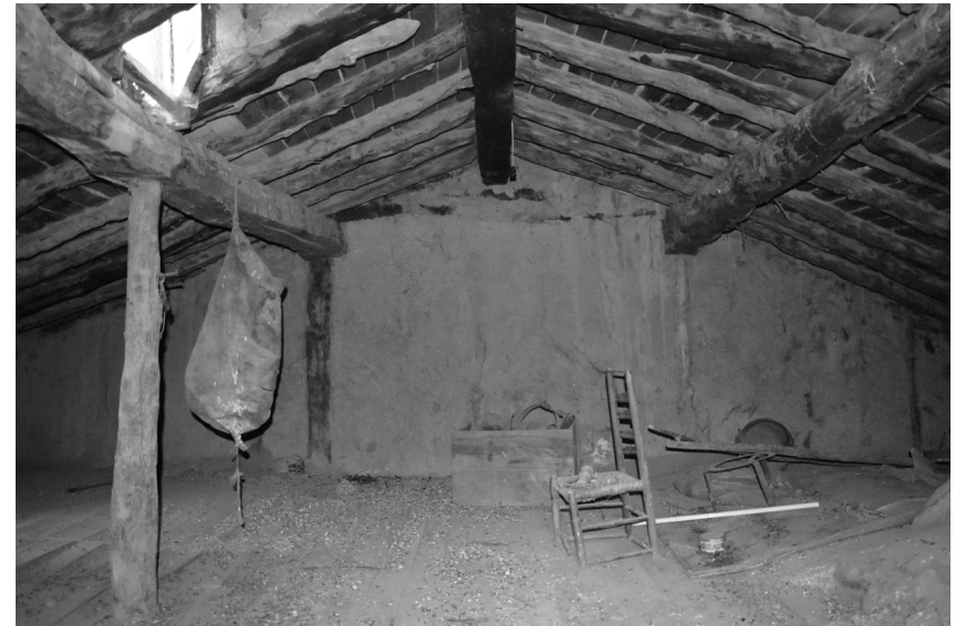
Espacio bajo cubierta. Cámara o almacén.
