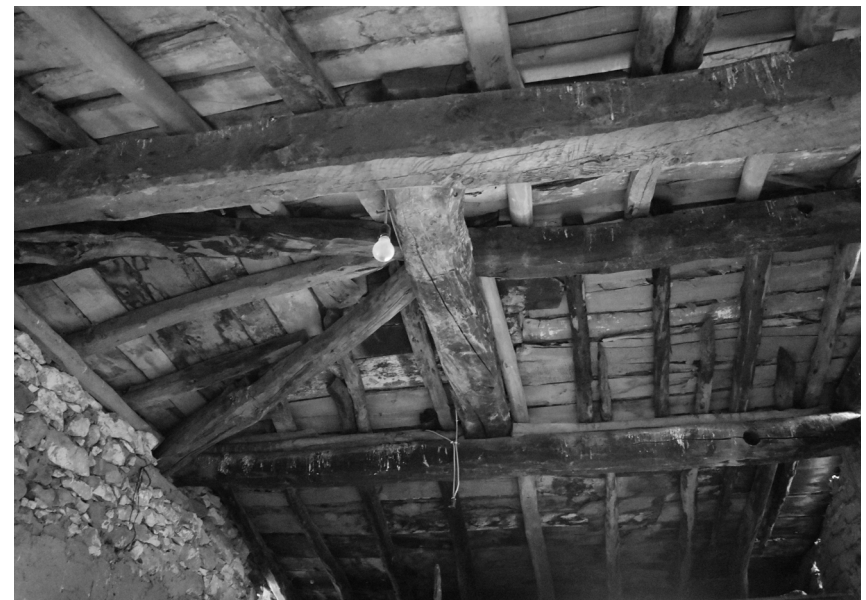
Estructura bajo cubierta, estancia de granero.
