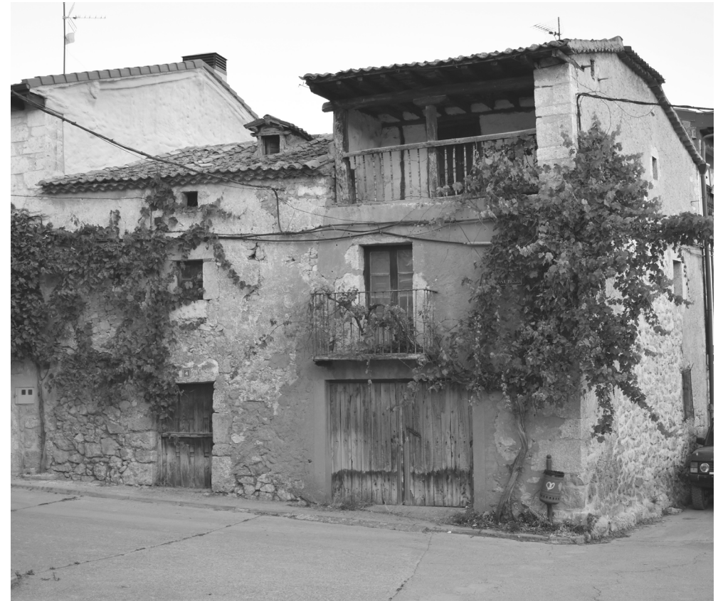
Imagen exterior desde plaza Bañuelos, estado actual. Fuente: Elaboración propia.
