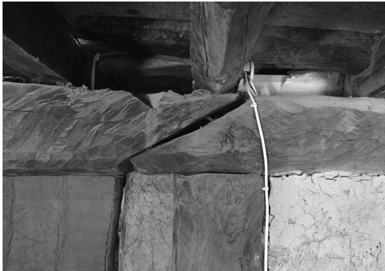
Encuentro de viguetas con muro de carga y vano de ventanal.
