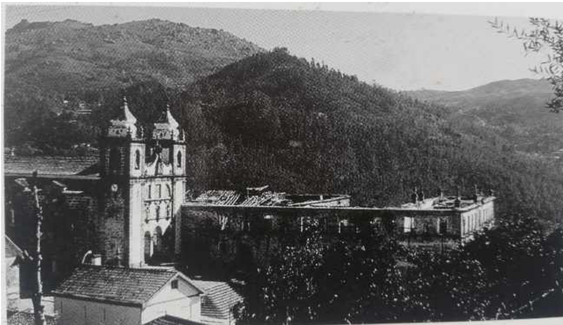
Figura 28: Vista general del monasterio antes de la intervención.
