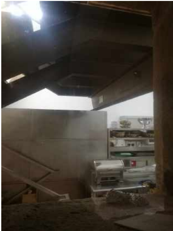
Figura 19: Escaleras de servicio (5)
