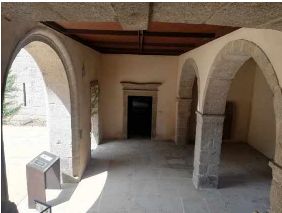
Figura 16: Recibidor en planta baja.
