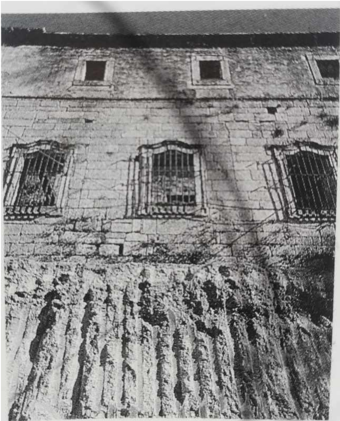
Figura 34: En esta foto podemos ver claramente la cimentación a base de pilotes sobre la que se asienta el muro exterior, ejecutada para realizar el vaciado del terreno frente a él, previo a la construcción del nuevo edificio de servicios.
