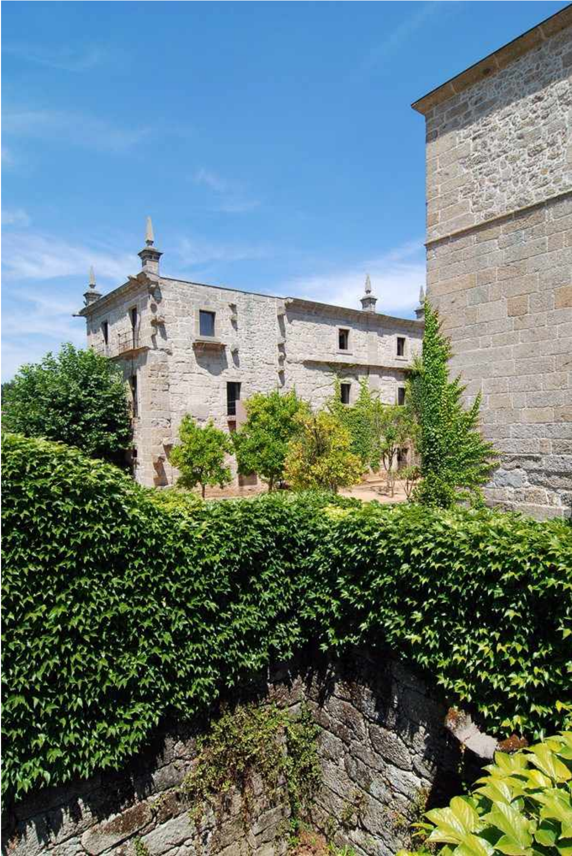
8. Vista del molino reconstruido.
