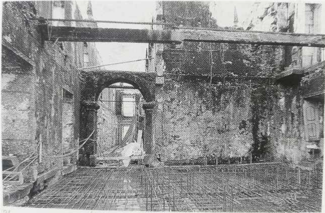
Figura 32: Armadura del forjado de planta primera antes del hormigonado.
