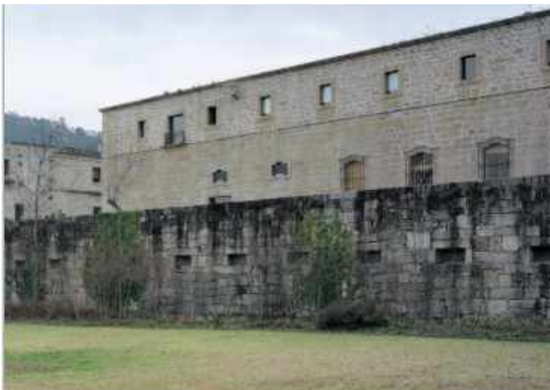
Figura 26: Fachada del edificio de servicios.
