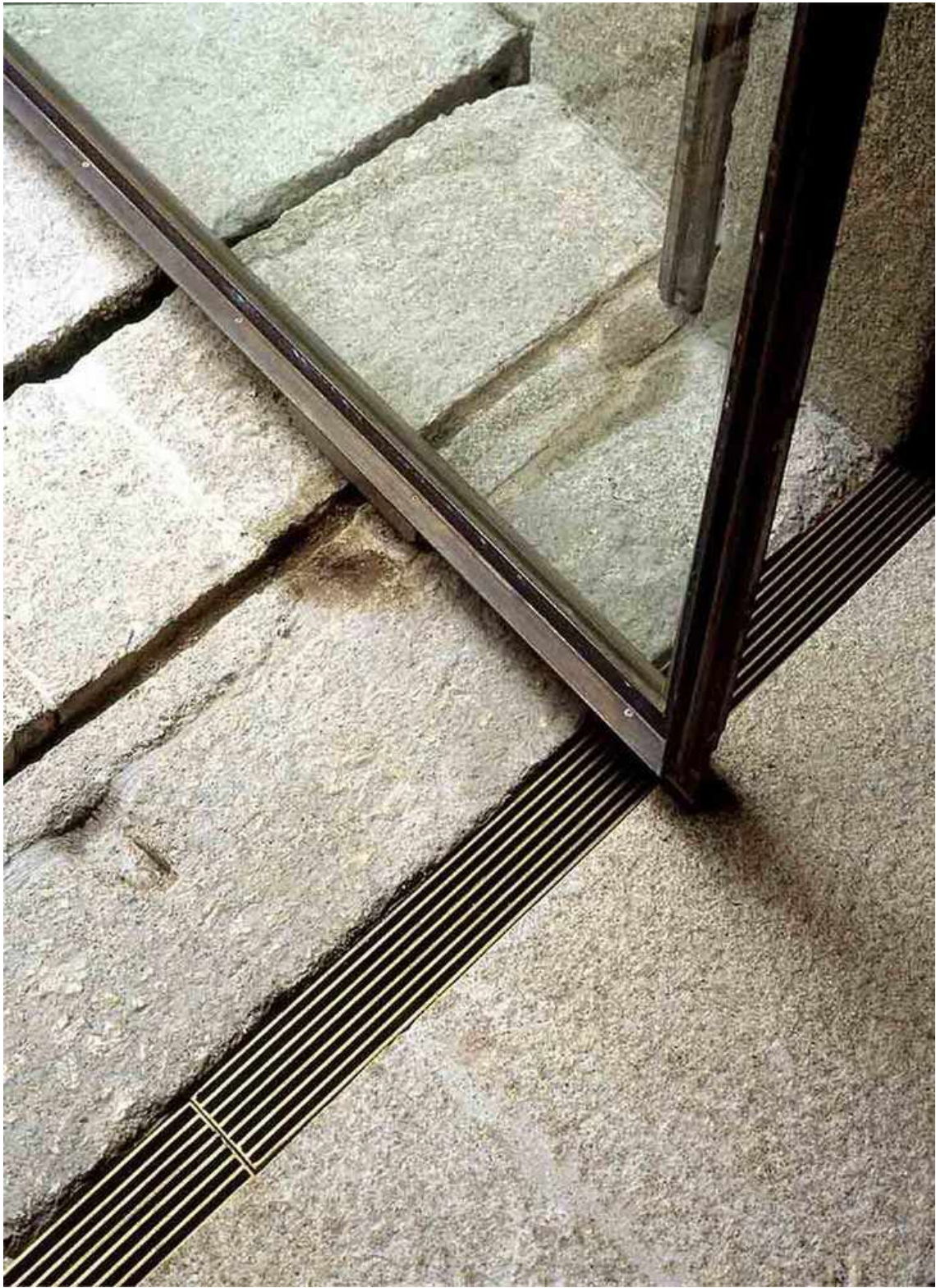
Figura 40: Detalle de rejilla de instalaciones y puerta.
