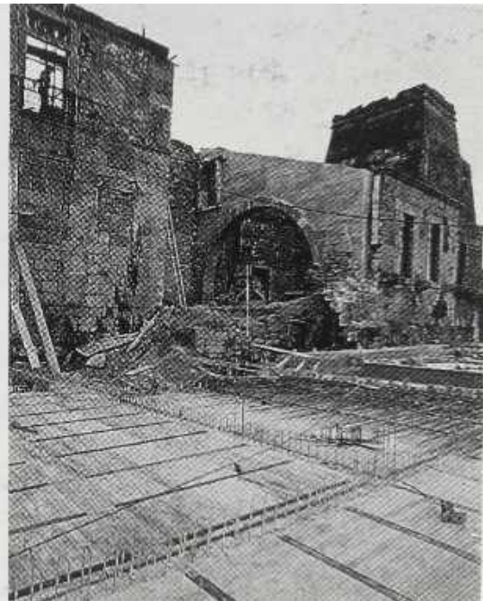
Figura 29: Fotos de la ejecución de la terraza sobre el edificio de servicios. A la izquierda un muro pantalla; a la derecha, el forjado bidireccional del edificio de servicios y la antigua cocina. El arco que se ve desaparece tras la construcción de una nueva dependencia.
