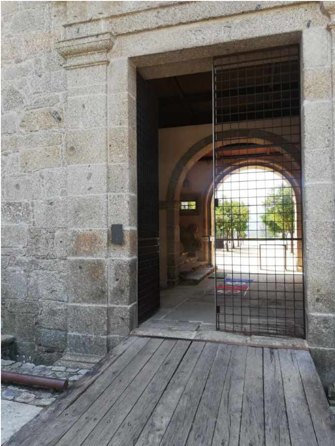
Figura 17: Entrada principal, con el patio de los naranjos al fondo.
