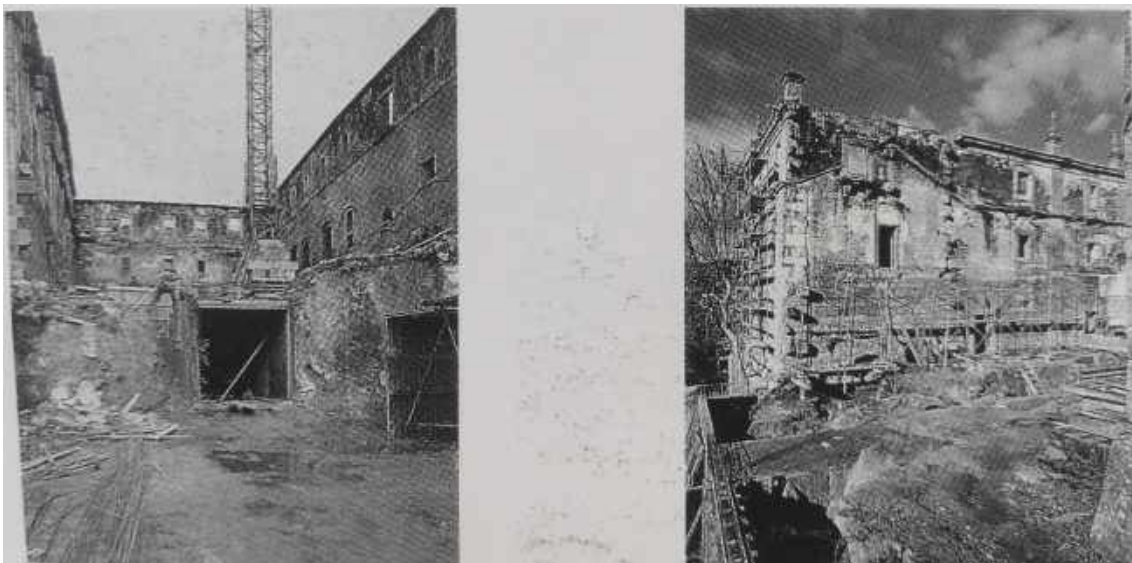
Figura 31: Imágenes del vaciado del actual patio de los naranjos para construir la planta sótano de servicios.
