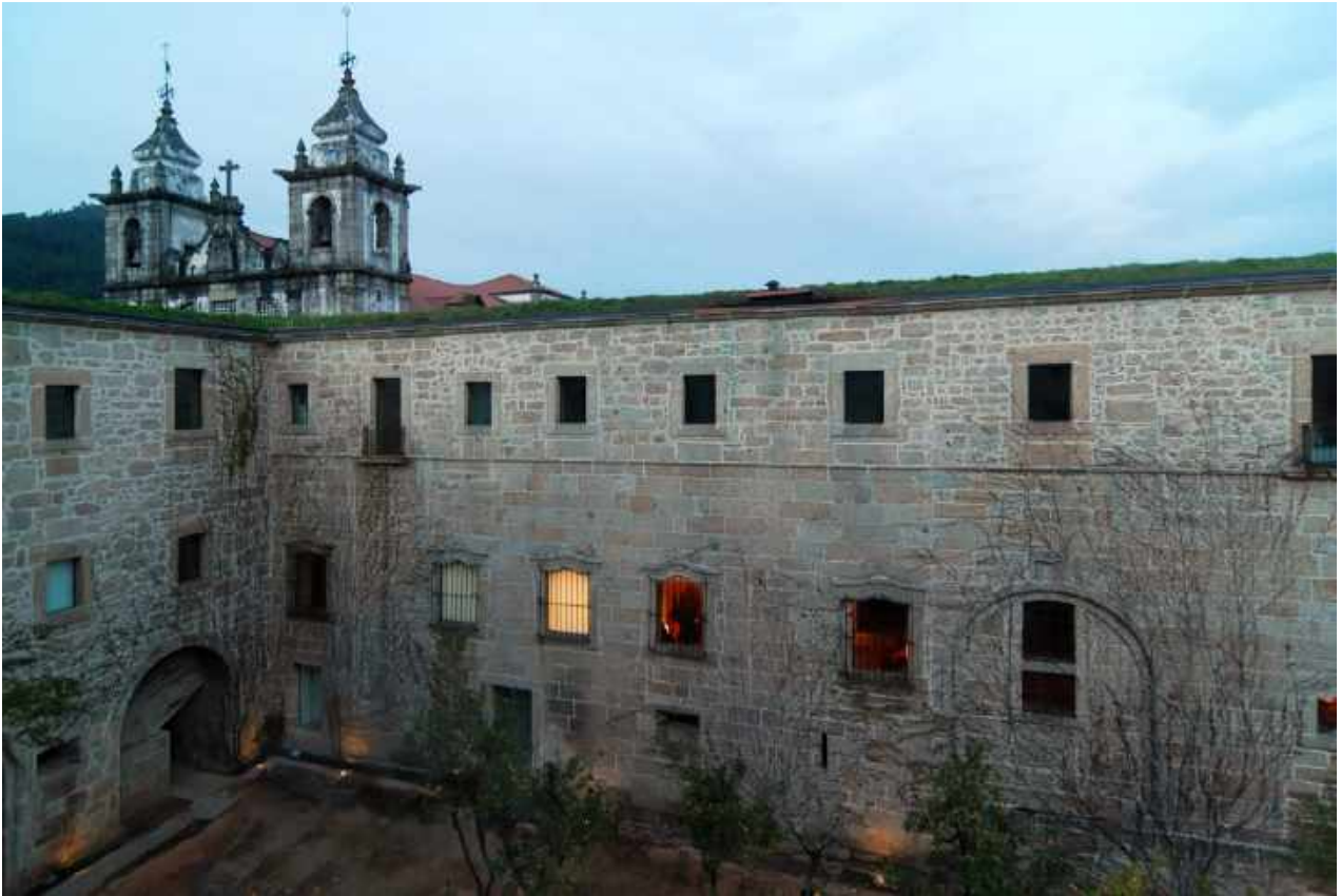
26. Patio de los naranjos desde la segunda planta.
