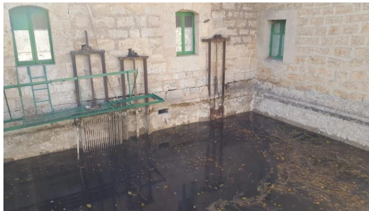
Ilustración 2. Bocas por donde pasa el agua a las diferentes turbinas del molino
