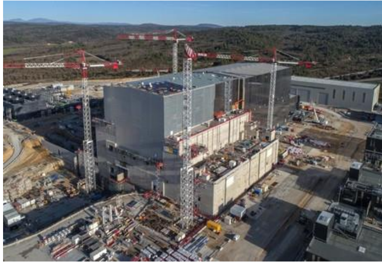
Ilustración 12. Proyecto ITER en construcción. Imagen tomada de: xataka.com
