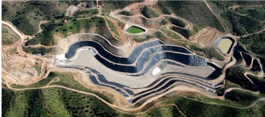
*Figura 4. Vertedero controlado en el que se aprecian las diferentes capas en forma de estratos naturales.*
