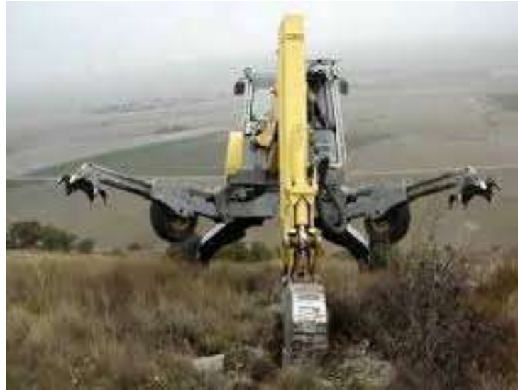
Figura 24: Retroaraña realizando hoyos (Fuente: victoryepes.blogs.upv.es )
