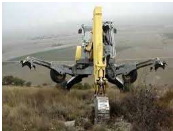
Figura 24: Retroaraña realizando hoyos (Fuente: victoryepes.blogs.upv.es )
