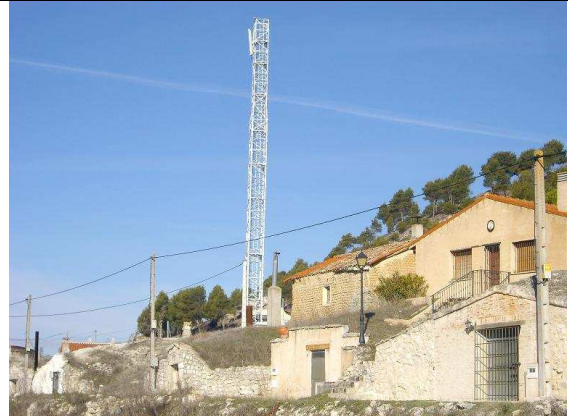
Corcos del Valle: Antena de telefonía móvil sobre zona de bodegas. Cableado más viviendas en terreno rústico y de protección más respiraderos sin tipología concreta.
