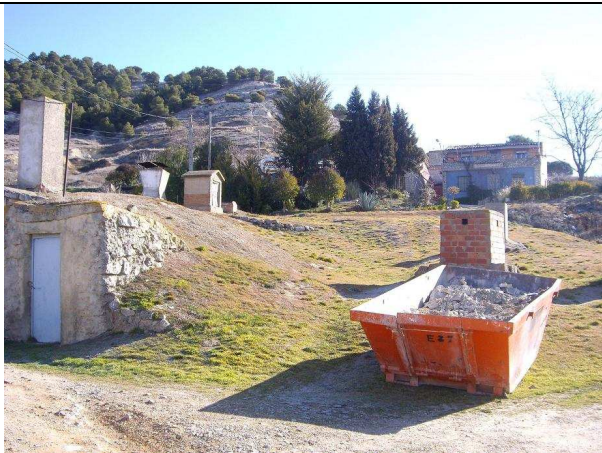
Cabezón de Pisuegra: Presencia de un contenedor. Respiraderos de diferentes tipos. Una vivienda ubicada en esta zona, donde residen personas.
