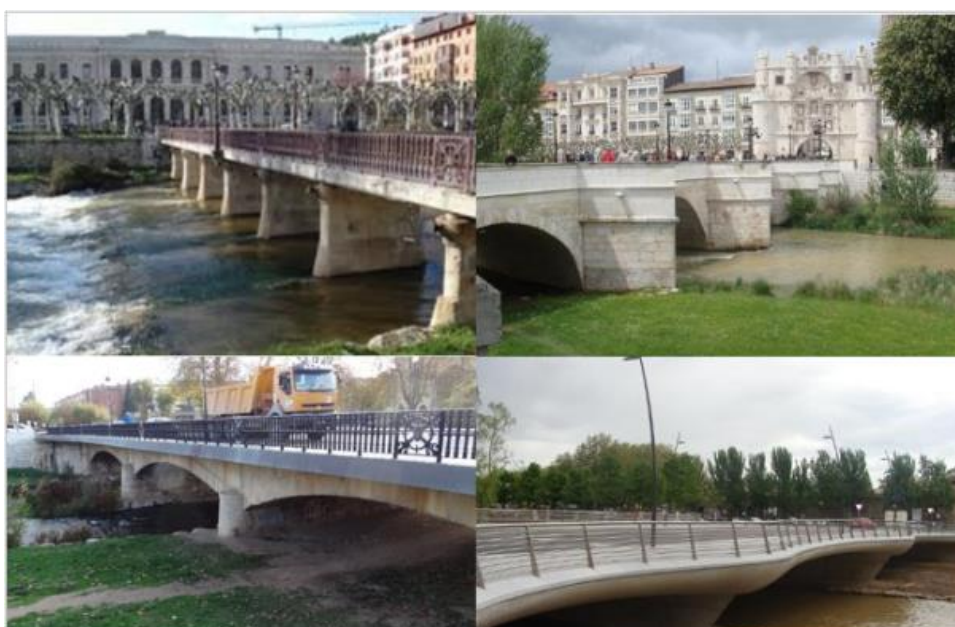
Fuente: elaboración propia. Ordenados de izquierda a derecha y de arriba abajo. Puente de Bessón, puente de Santa María, puente de Castilla y puente Gasset.
