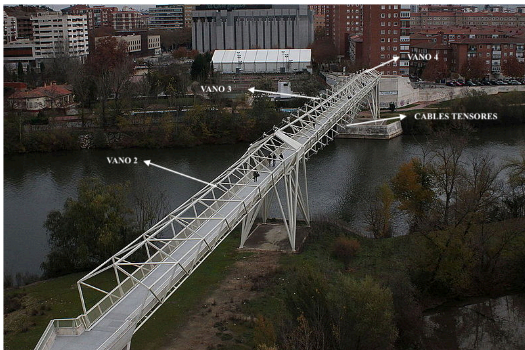
Figura 5.3. Localización de los vanos en la pasarela
