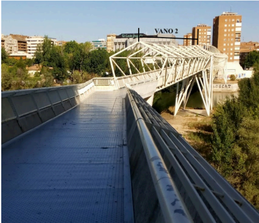
Figura 5.4. Vano 2 de la pasarela peatonal
