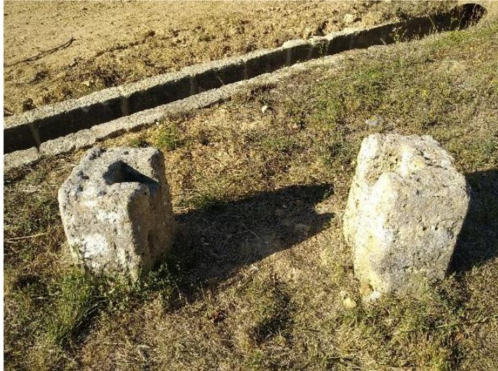
Ilustr.6) Restos conservados del sistema de apertura de las compuertas de una esclusa. Calahorra de Ribas.
