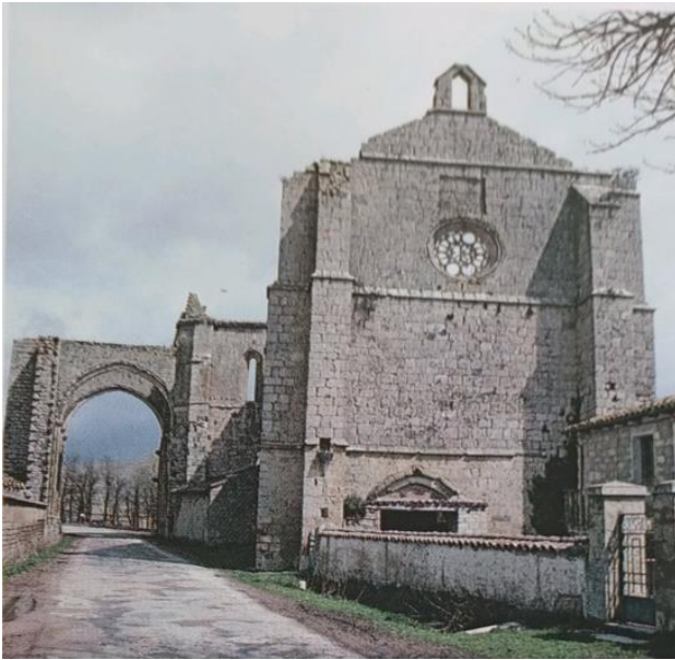
Fig. 10 Castrojeriz. Convento y hospital de San Antón. Muros de la iglesia y pórtico
