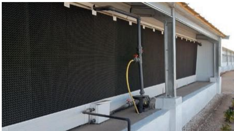
Ilustración 3: Panel evaporativo, y pasillo adicional. (Fuente Big Dutchman)
