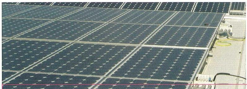
En las instalaciones sobre tejado se alcanza temperaturas superiores a 90 °C con frecuencia. El cable Tecsun está diseñado para soportar estas temperaturas
