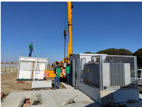
Figura 9. Instalación estación inversión junto a transformador [Quinto Armónico]
