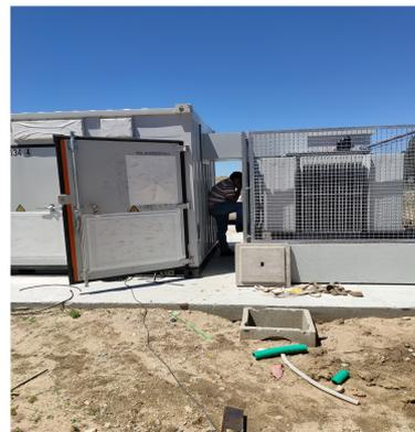
Figura 10. Unión inversor-transformador [Quinto Armónico]
