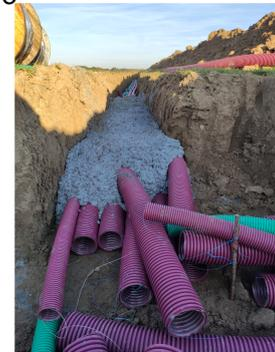
Figura 13. Tendido tuberías [Quinto Armónico]
