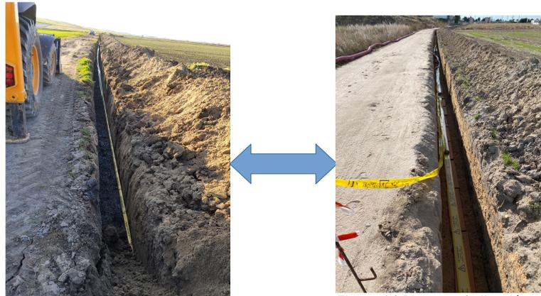
Figura 14. Placas señalización conductores eléctricos [Quinto Armónico]
