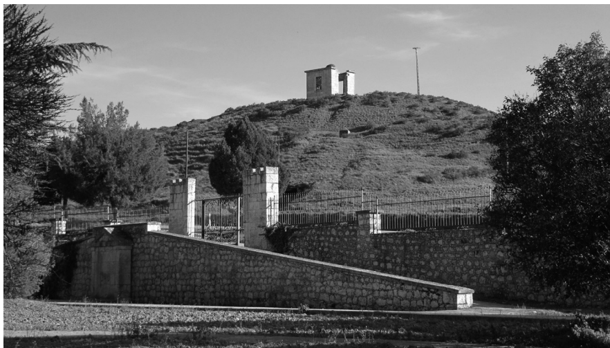
Fig. 66. Ventosilla. Acceso a la Casa y fuente, con la torre al fondo.
