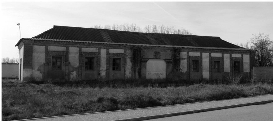
Fig. 43. Real Sitio de El Abrojo, restos de la Casa.
