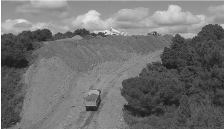
Fig. 7.12. El abandono y desmantelamiento de parte del trazado antiguo ha permitido el retorno de nuevas superficies al parque natural.
