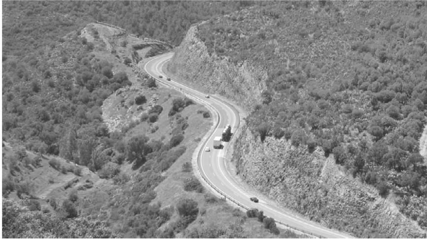
Fig. 7.8. La restauración de los grandes desmontes y tramos en trinchera recibió una atención particular en el proyecto de restauración de la época del desdoblamiento.
