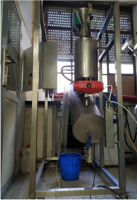
Ilustración 10. Planta de tratamiento de hidrólisis térmica
