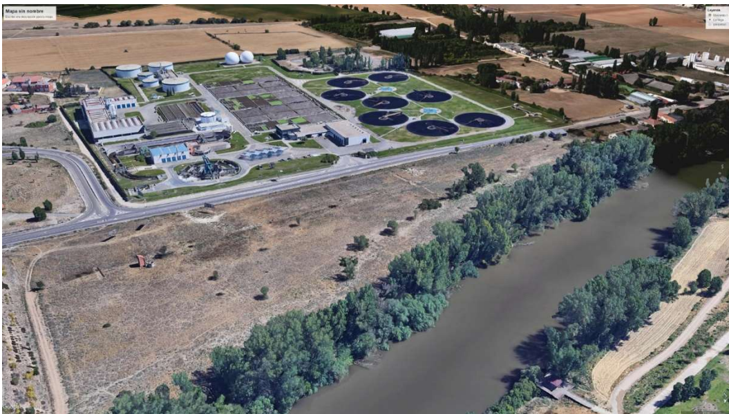
Ilustración 1. EDAR de Valladolid
