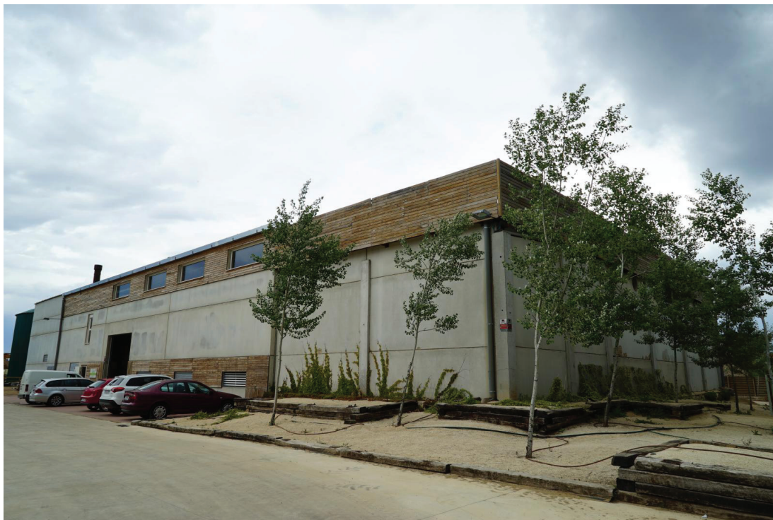
Central térmica de la red de calor de Soria. Fuente: Rebi Recursos de la Biomasa.
